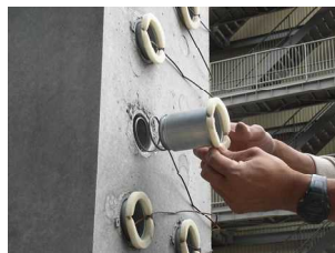
梁ジョイント部
