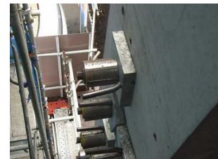
梁緊張後状況
