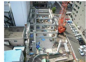
大梁架設状況
