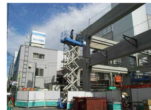
鋼線挿入状況
