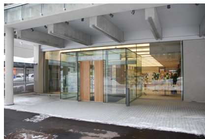
図7 玄関廻り(細柱・床版リブ)
