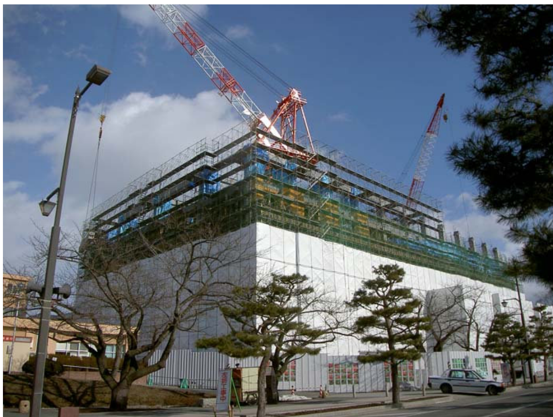
南西外観 施工状況
