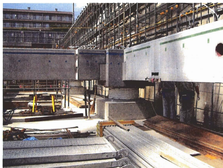
免震装置まわり施工状況
