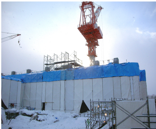
シート被覆養生外観
