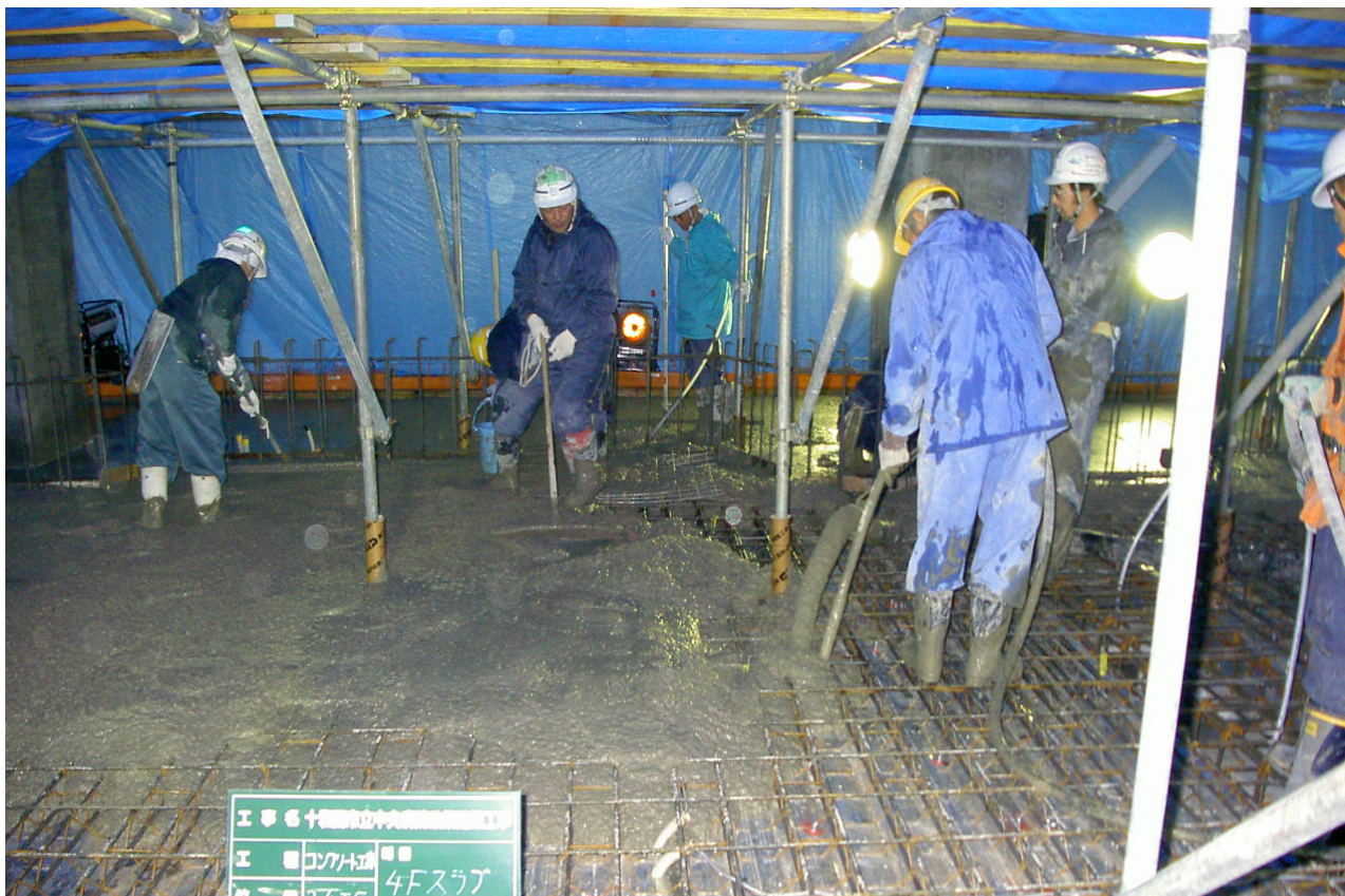
シート被覆養生内でのスラブコンクリート打設状況
