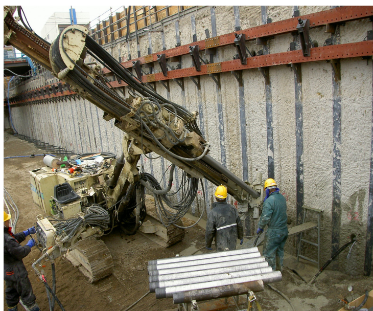
アースアンカー 施工状況
