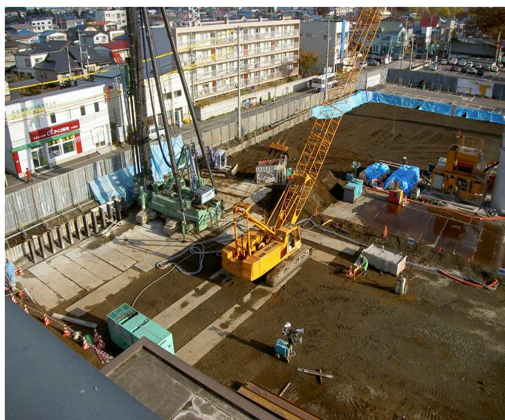
SMW 施工状況
