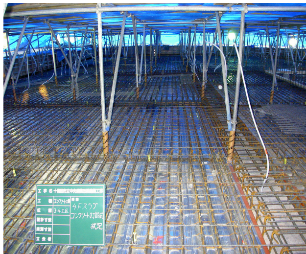
スラブシート被覆養生
