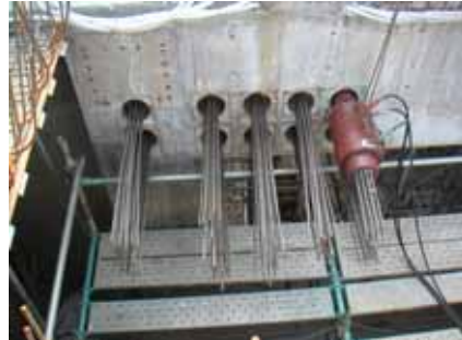
写真-20 エントランス屋根現場緊張
