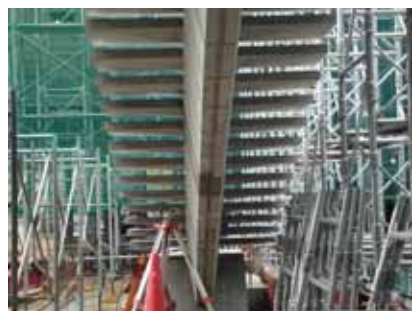
写真-24 エントランス階段現場設置状況
