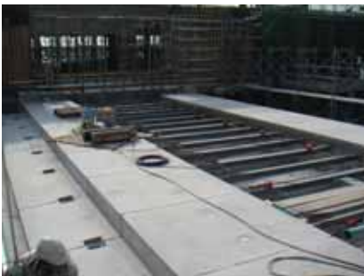
写真-19 エントランス屋根設置終了
