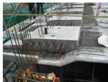
写真-14 ST床版設置状況
