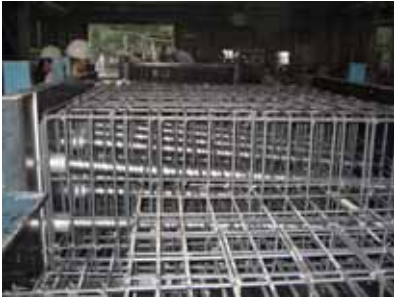
写真-15 エントランス屋根配筋状況
