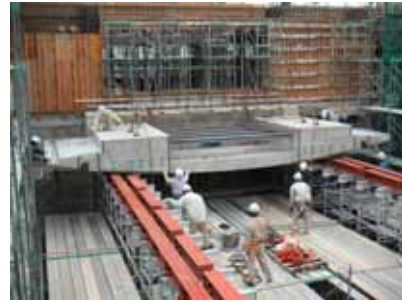
写真-18 エントランス屋根設置状況
