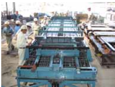
写真-9 ST床版配筋状況
