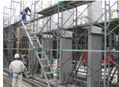
写真-8 PC柱建方状況
