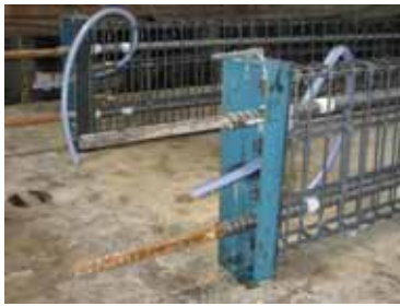
写真-5 PC柱配筋状況
