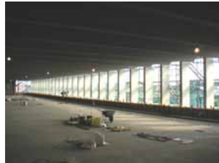
写真-28 南面窓廻り
