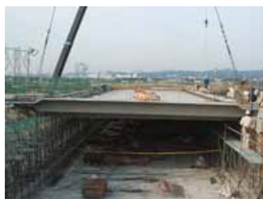
写真-13 ST床版建込み状況
