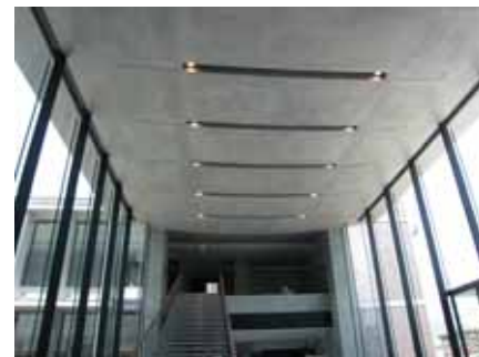
写真-32 エントランス屋根見上げ
