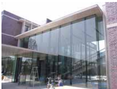
写真-31 エントランス外観
