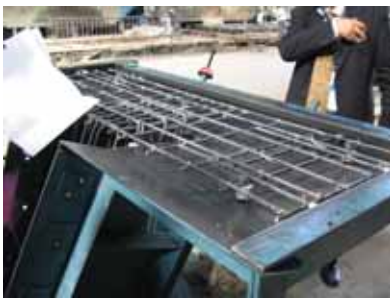
写真-21 エントランス階段配筋状況
