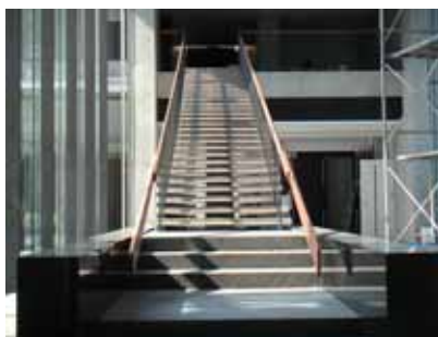
写真-33 エントランス階段
