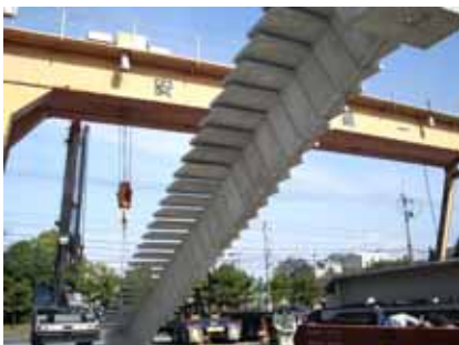
写真-23 エントランス階段工場組み立て状況
