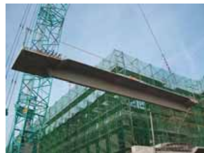
写真-12 ST床版建込み状況
