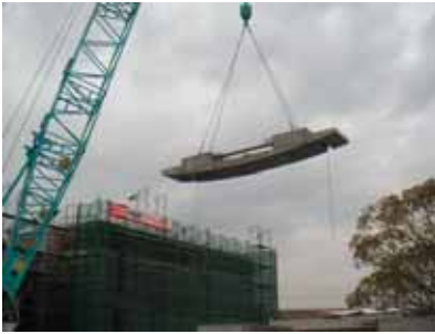
写真-17 エントランス屋根建込み状況
