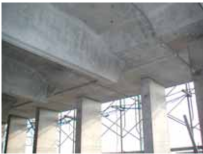
写真-29 PC柱 - ST床版接合部
