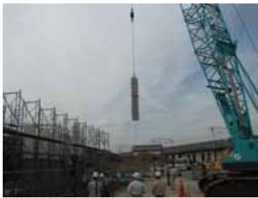
写真-7 PC柱建込み状況
