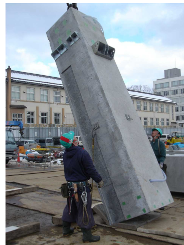
写真 - 10 PCa柱建起し状況
