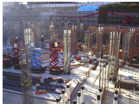
写真 - 9 B1階 PC鋼棒 取付け状況
