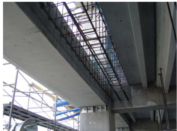
写真 - 7 ブリッジ連結部
