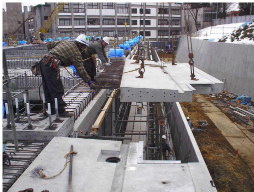
写真 - 12 バルコニー版 架設状況
