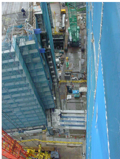
写真 - 13 2階 西 ブリッジ・庇版 架設状況
