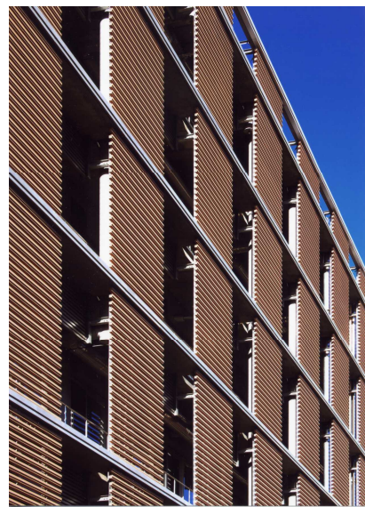
写真 - 2 外装 セラミックルーバー
