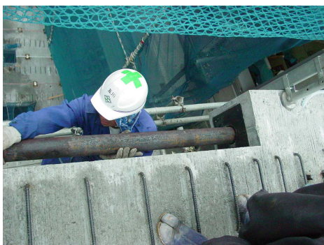
写真 - 14 7階 ブリッジ版 タイロッド挿入状況
