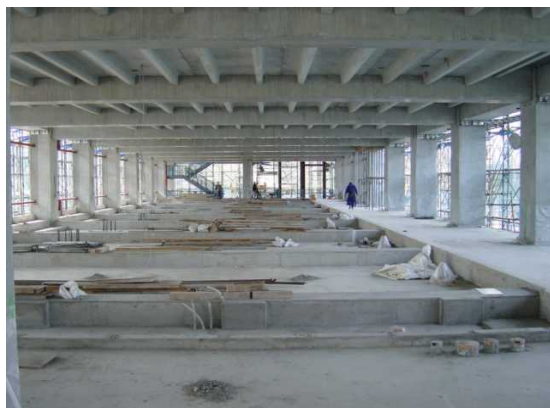
写真 - 6 スラブ段差 (トップコン打設完了後)
