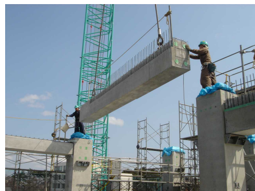
写真 - 11 PCa梁架設状況(スパン梁)
