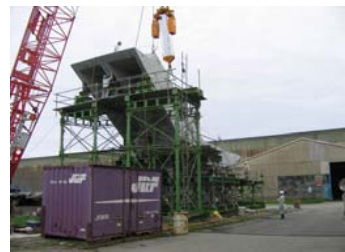
⑩Cスラブ組立状況
