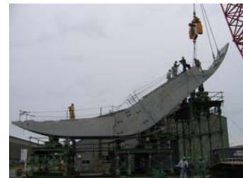
⑪W版組立状況 (単体重量14t)
