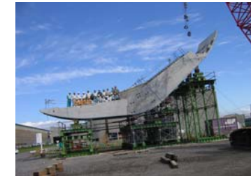
⑯組立完了状況
