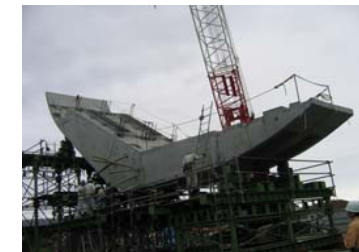
⑫シース管エアフェンス挿入試験
