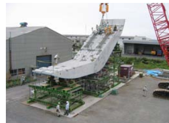
⑭組立完了状況
