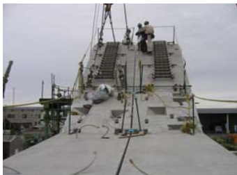
⑨Cスラブ組立状況 (傾斜角度33°)
