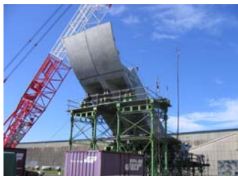
⑬組立完了状況
