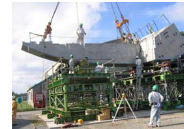
④Aスラブ組立 (単体重量29t)
