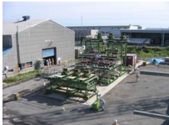
①ベント組立状況
