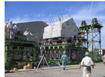
③B桁組立完了
