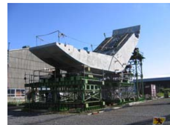
⑮組立完了状況
