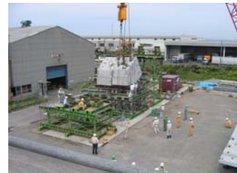
②B桁組立 (単体重量39t)
