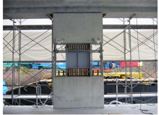
写真3 鉄骨制振間柱
