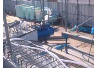
6. トップコン打設 PC鋼筋緊張作業
