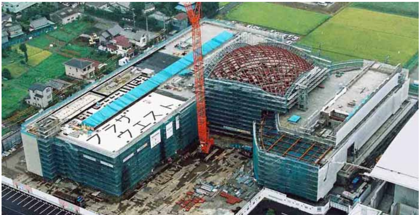
写真-1. プラザウエスト全景
