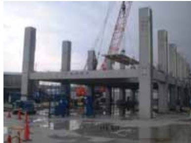
5. PC床版架設 トップコン打設準備開始
