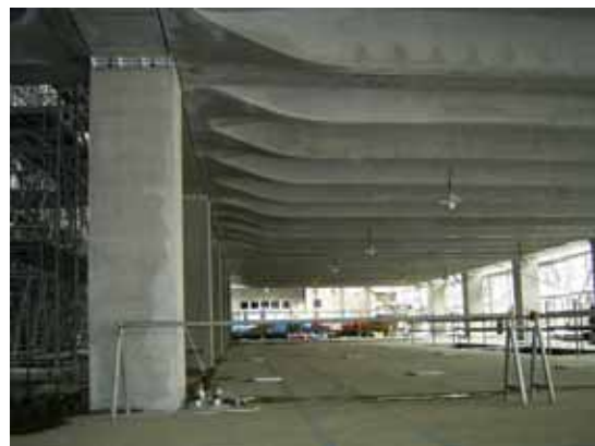
fig.10/11 現場に組み立てたPC床版(1階図書館)
