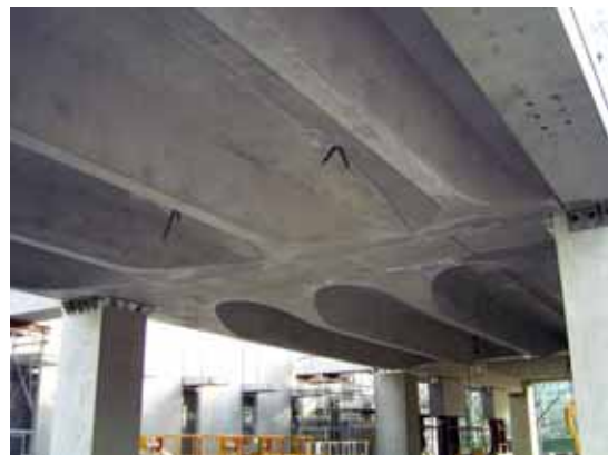
fig.9: 脱型直後のPC床版
