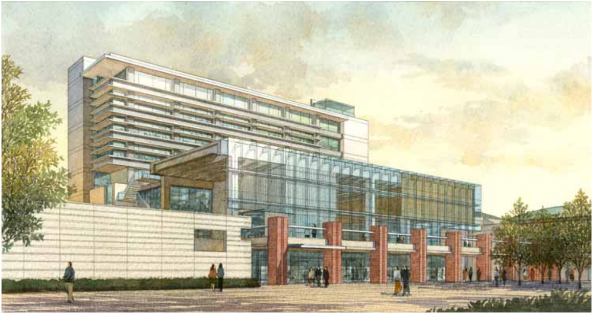
fig.2 :研究教育情報関係施設の外観。構造も外装も全て PC。ガラス張りの低層部には多目的ホールを収容。
