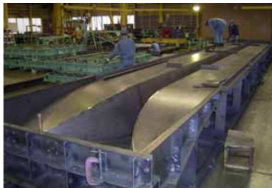
fig.7:PC 床版金属型枠
