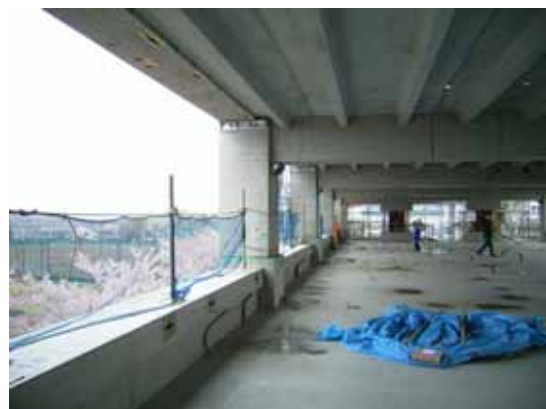
fig.12: 既成型枠PC床版(基準階に使用)
