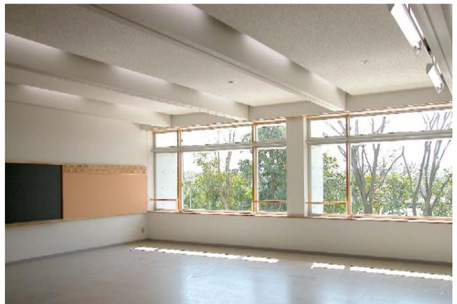
fig3 教室内部: 天井が明るいのはライトシェルフからの反射のため
