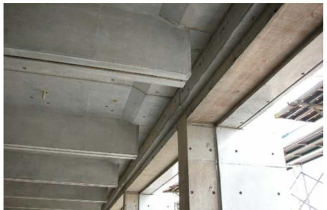
fig4: PC 梁と現場打ちコンクリートの取り合い
