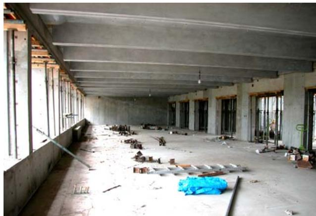
fig6: 工事中の教室-支保工は現場打ち部分のみに使われている。
