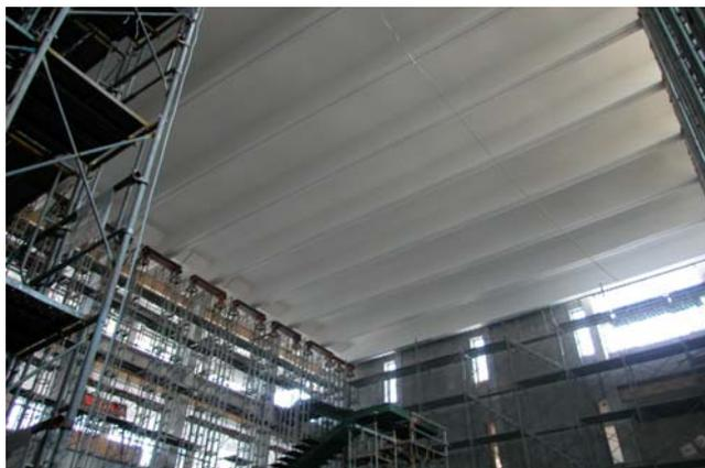
fig9: 工事中のアトリウム-大足場を架けることなく施工できた。
