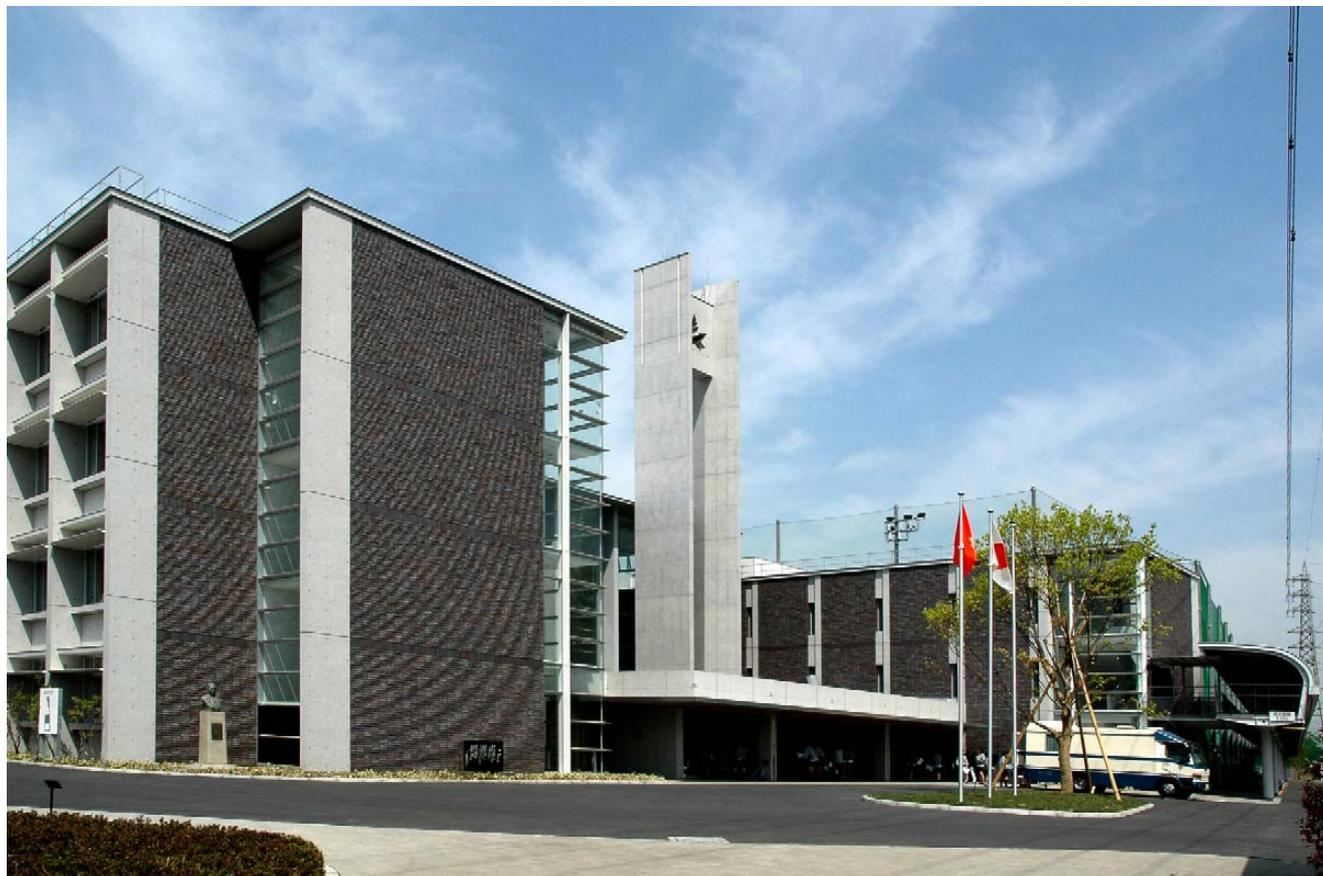
fig.1: 拓殖大学第一高等学校の外観—外装は化粧打放しコンクリートとレンガタイル張り。PCは外部には表われていない。
