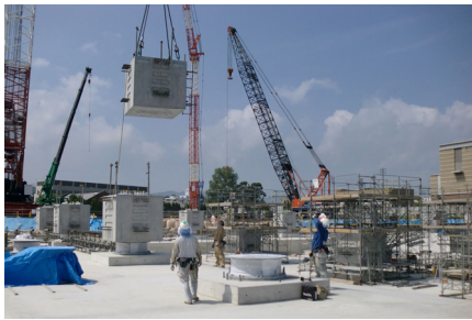
免震ブロック架設
