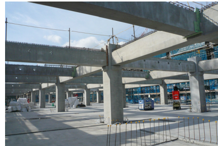
PCa小梁の架設
