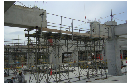
中間PCaブロック梁の架設
