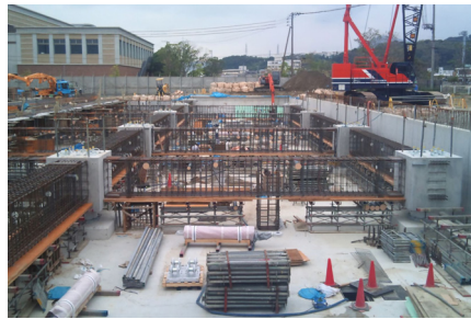
1階RC梁の配筋
