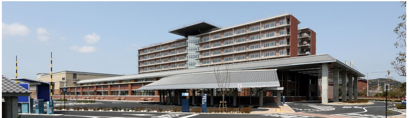
写真-1.2 建物全景(南面) ※1
