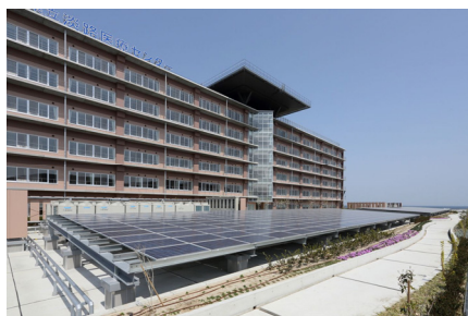
低層部 屋上太陽光パネル
