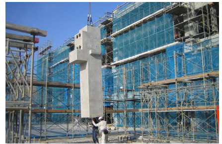
1階PCa柱の架設
