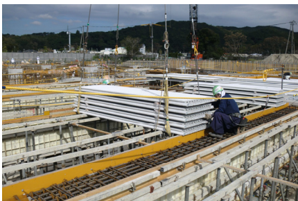
PCa床版の架設
