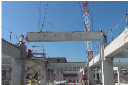
PCa大梁の架設
