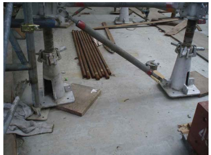
ジャッキベースの移動
