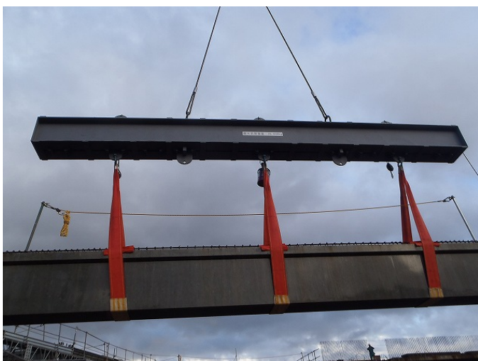
PC梁一時撤去状況
