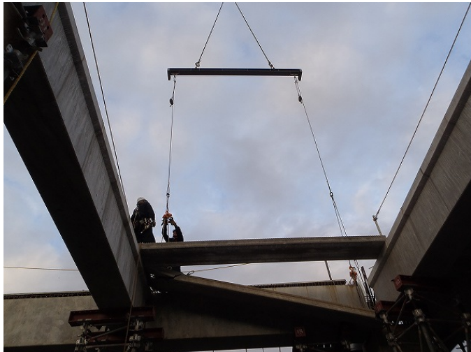
PC床一時撤去状況
