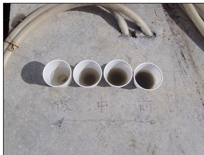
シース管内の洗浄状況
