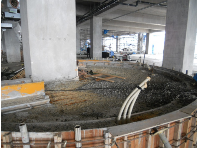
高層棟：震災当日打設のコンクリート状況
