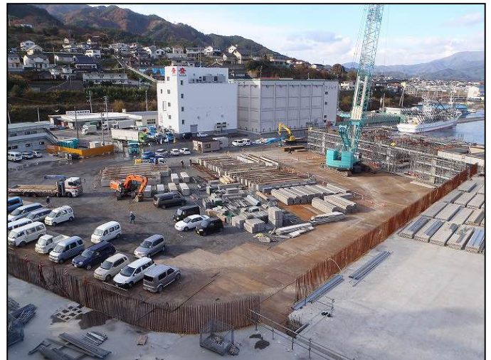
PC床梁場内一時仮置き状況
