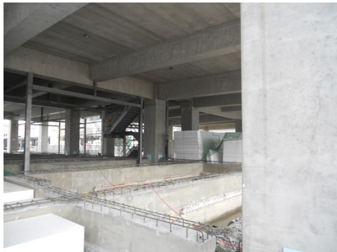
1階床嵩上状況
