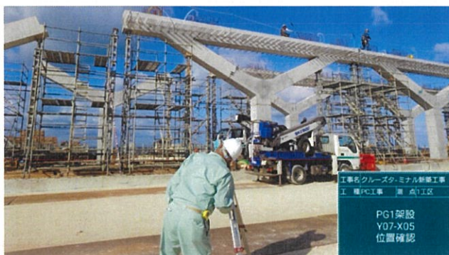
写真-14 測量状況2
