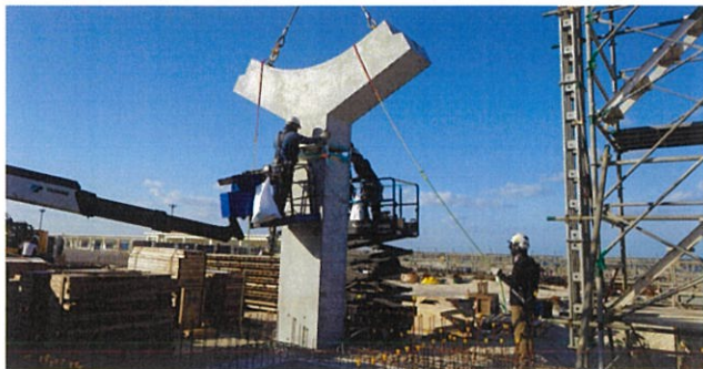
写真-8 YG柱の架設
