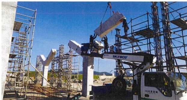
写真-9 PT梁の架設1
