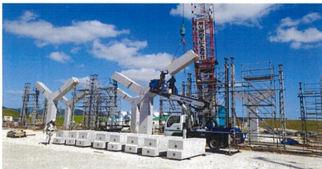
写真-10 PT梁の架設2
