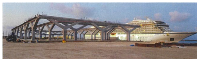
写真-4 PC部材が上がった現場2
