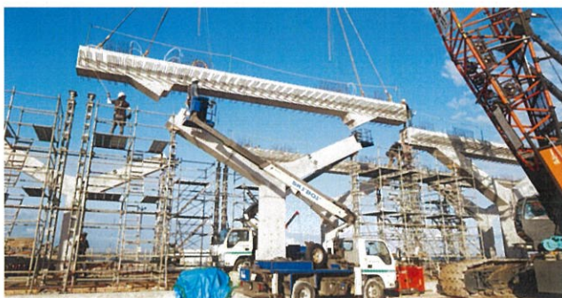
写真-11 PG梁の架設
