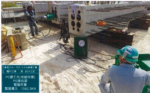
写真-12 PG梁の緊張状況
