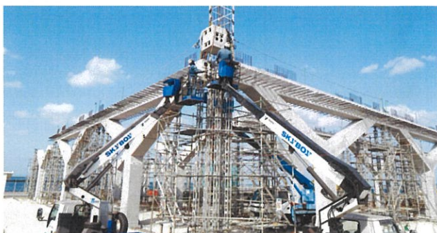
写真-12 コーナー部材の架設
