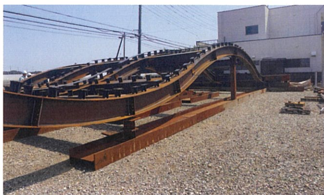
写真-5 屋根鉄骨仮組状況
