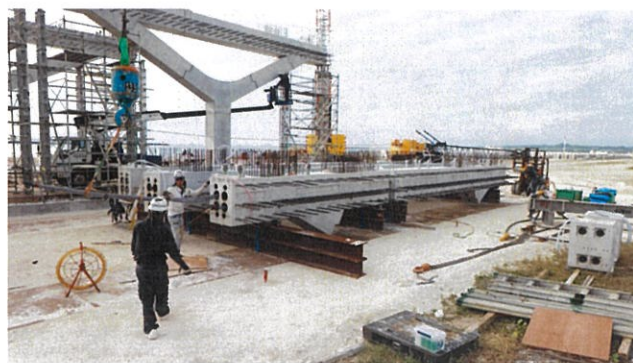
写真-7 PG1組立状況
