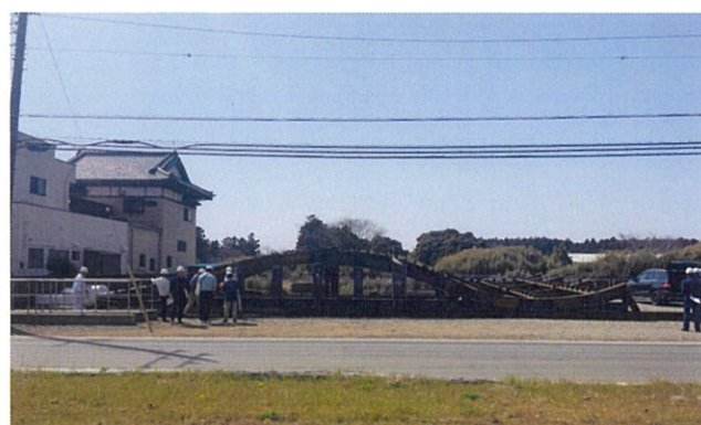
写真-6 屋根鉄骨部材ワンユニット
