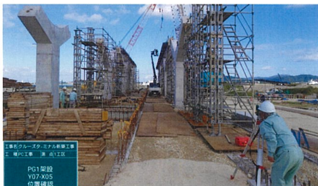
写真-13 測量状況1
