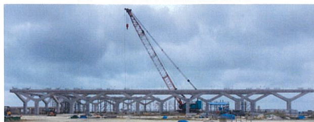
写真-3 PC部材が上がった現場1
