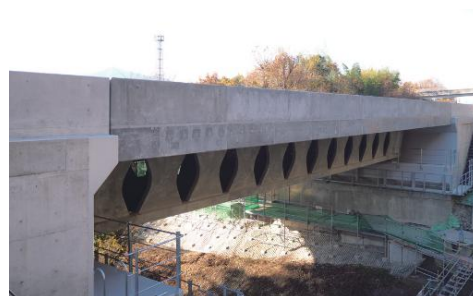
鋼材を使用しない超高耐久橋梁
