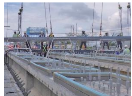
PC 合成桁橋の床版取替えの施工例
