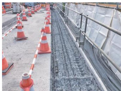
PC 合成桁橋の床版取替えの施工例
