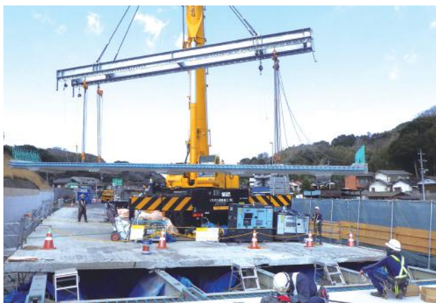
高品質であるプレキャスト PC 床版への取替え
