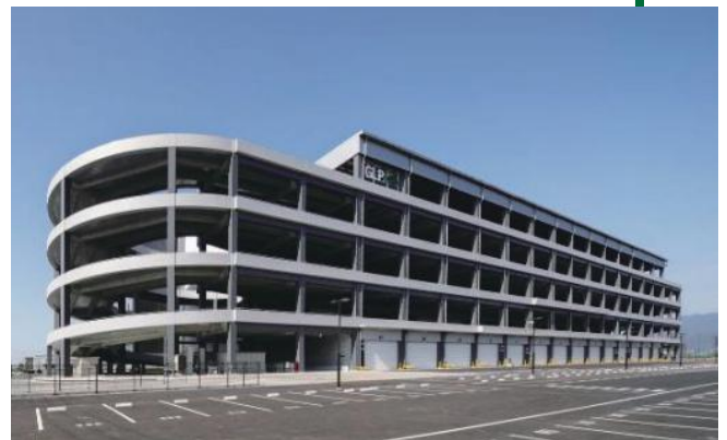
自由度が高く、高い保管効率が求められる物流倉庫に、 PCaPC+免震構造が採用された
