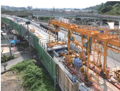
高速道路リニューアルプロジェクトによるPC床版取替工事
