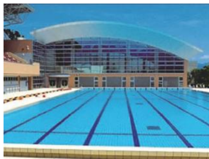
プレキャストPC製品を側壁に使用したプール
