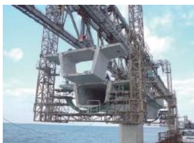
スパンバイスパン工法による省力化施工
