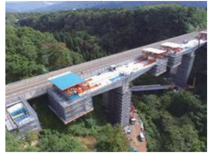
4車線化のため供用自動車道に隣接して架橋されるPC橋
