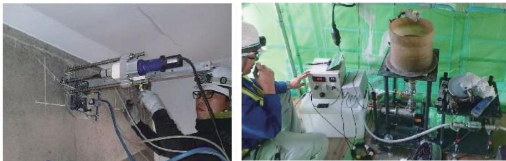
既設構造部への削孔を最小限にしたシース内の空洞量測定システム
