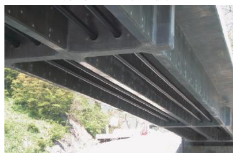
場所打ち施工された超高強度繊維補強コンクリートによる橋梁
