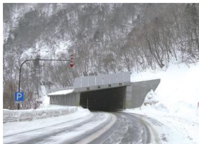
防災・減災に貢献するスノーシェッド
