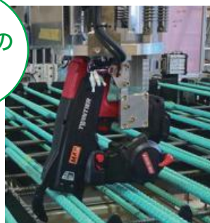
鉄筋結束の自動化
