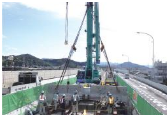
プレキャスト横梁架設状況
