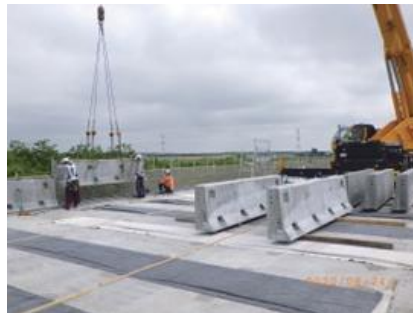
PC床版取替工において壁高欄にプレキャスト部材を用いた生産性向上策
