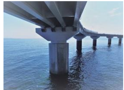
海上における橋脚の耐震補強にPC技術を用いた工事
