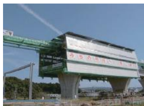
移動支保工を用いた省力化施工
