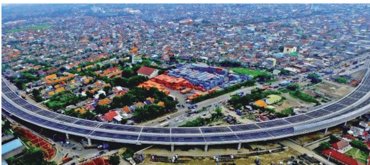
CIM活用したU型PC桁高架橋(インドネシア)
