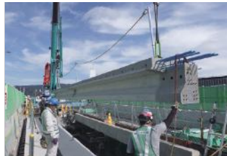
主桁架設状況
