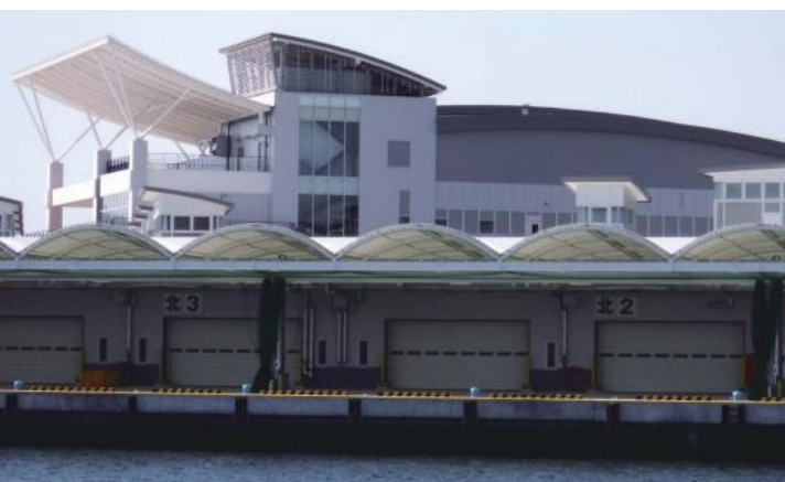
機能上スパンが長く階高が高い空間、駐車場に伴う荷重、塩害対策が求められた魚市場にPCaPC造が採用された
