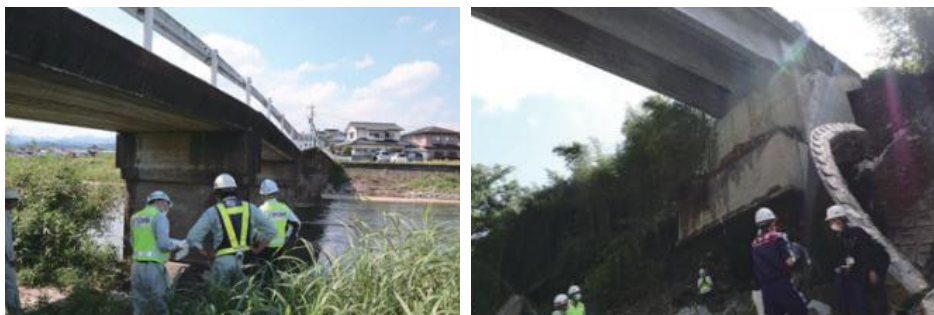
災害後の橋梁点検状況
