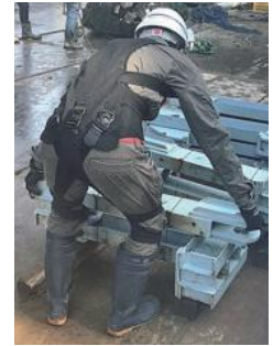
パワーアシストスーツ着用での作業状況
