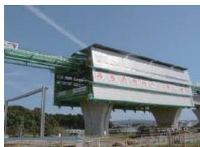
移動支保工を用いた省力化施工
