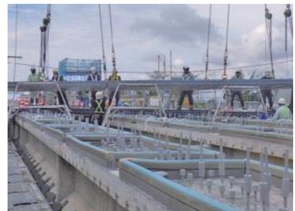
PC合成桁橋の床版取替えの施工例
