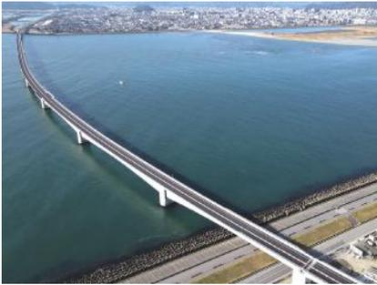
ミッシングリンク解消のため河口に架橋されるPC橋
