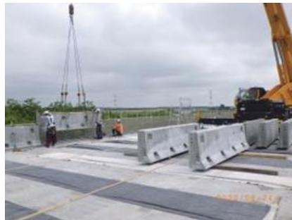
PC床版取替工事において壁高欄にプレキャスト部材を用いた生産性向上策
