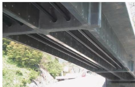
場所打ち施工された超高強度繊維補強コンクリートによる橋梁
