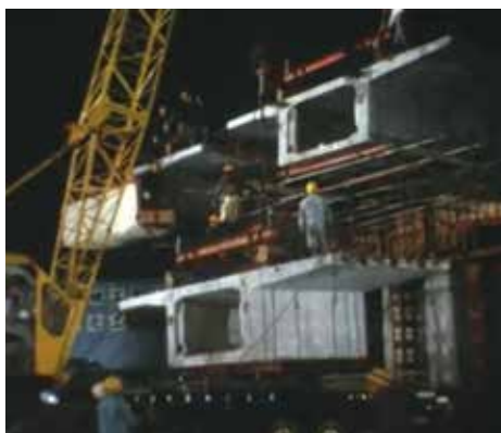
▲ 写真-4 深夜における架設状況
