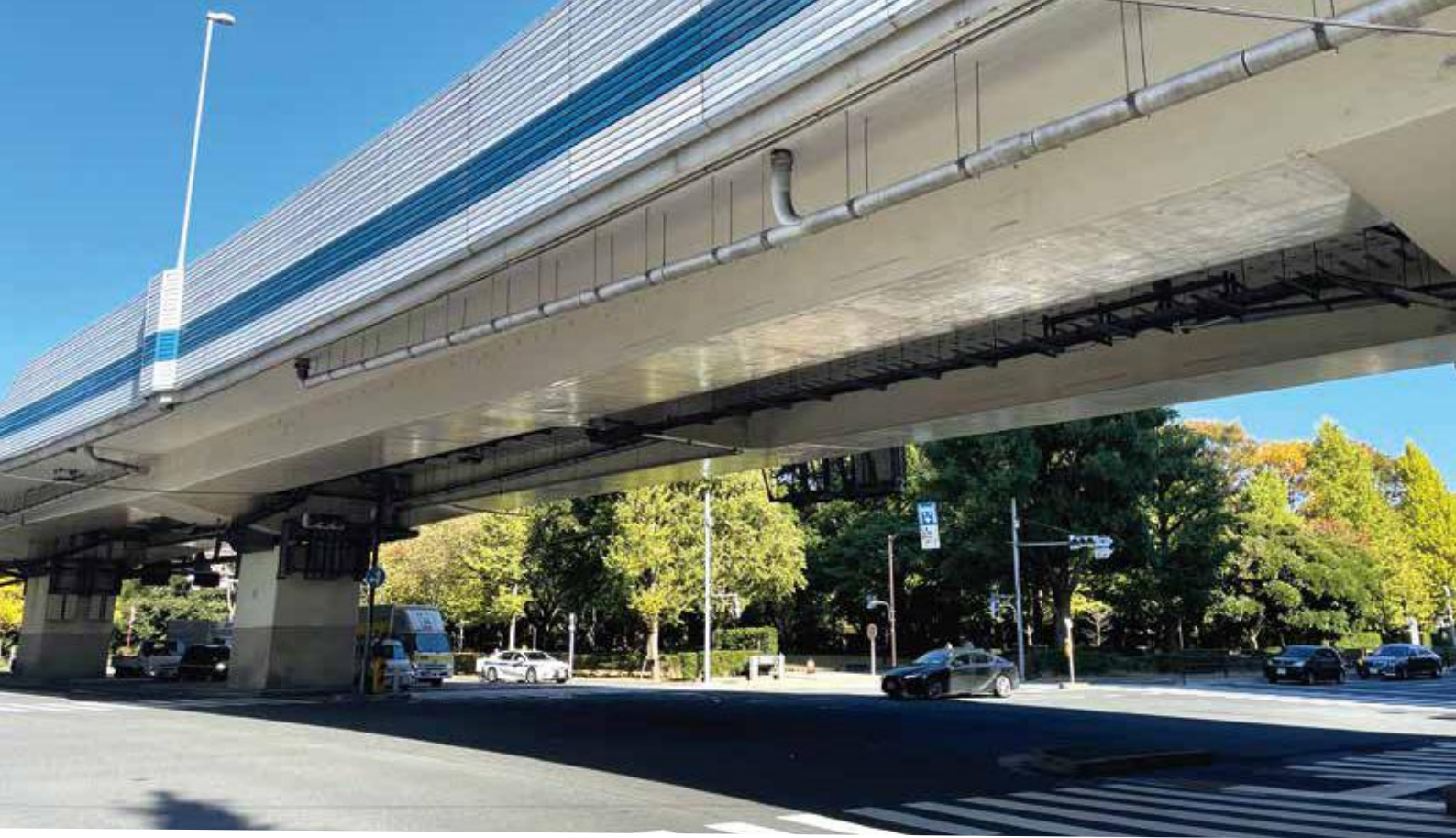
▲写真-1 現在の目黒架道橋
