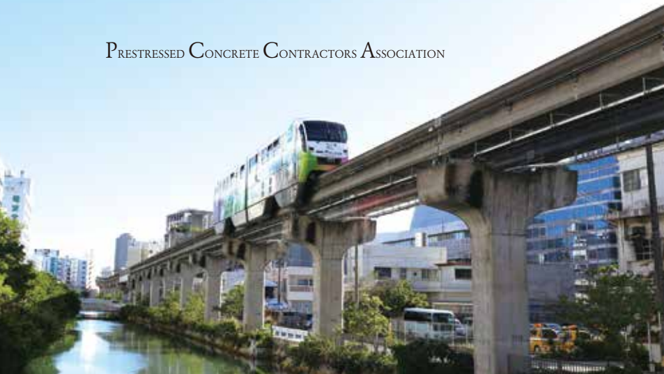
▲ ゆいレール 沖縄唯一の軌道系交通であるモノレール。平成10年からPC軌道桁の設置を開始し、平成15年に那覇空港駅～首里駅が開通。その後那覇IC近くのとてこ浦西駅まで延伸。
