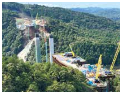
▲現在、従事している信楽川橋の作業現場
