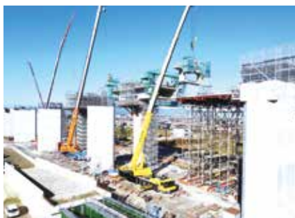
▲城陽第二高架橋西でのセグメント架設状況
