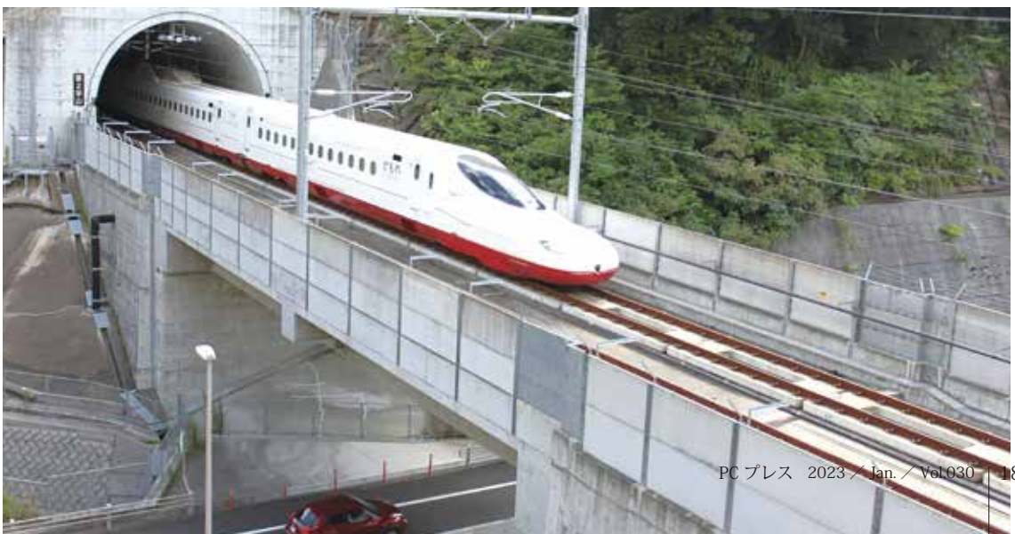
▼写真-4 原種架道橋全景
