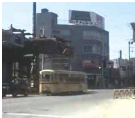
▲ 写真-3 架設前状況(都電通り)
