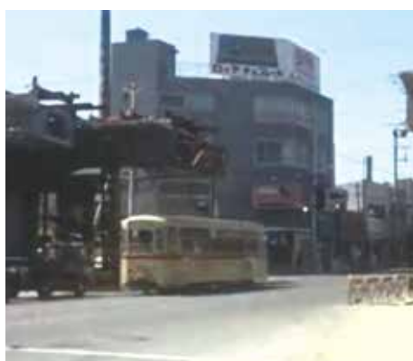
▲ 写真-3 架設前状況（都電通り）
