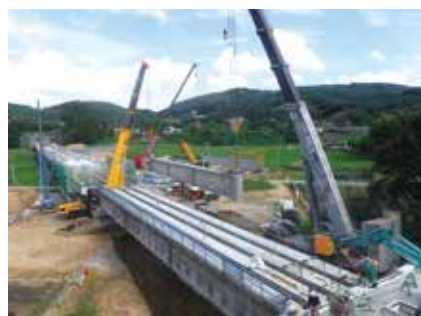
▲ 思い出の現場(架設状況)
