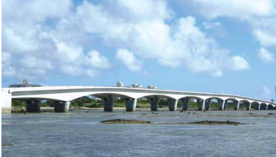
▲カーミージー橋 沖縄西海岸道路ののり面立て計画変更に伴い、平成30年に完成したPC11径間連続箱桁橋。塩害の激しい海上橋のため、大型架設作業車を用いて施工ブロック数を減らし、PC品質を確保。
