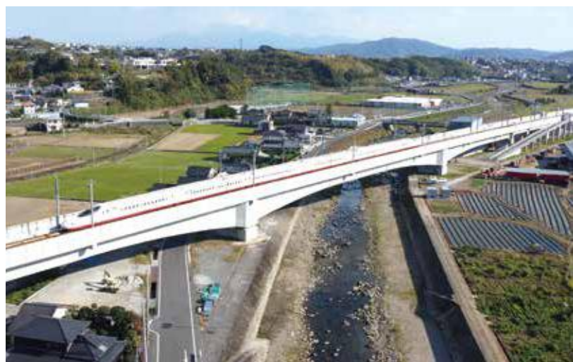
▲写真-2 第2本明川橋梁全景
