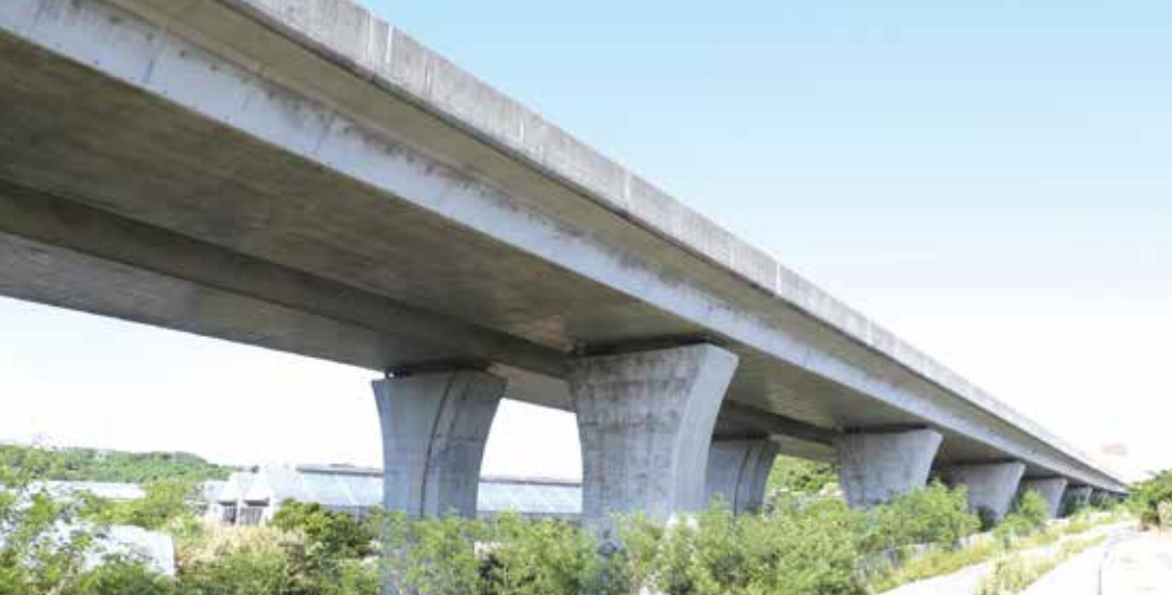
▲ 饒波高架橋(那覇空港自動車道)
