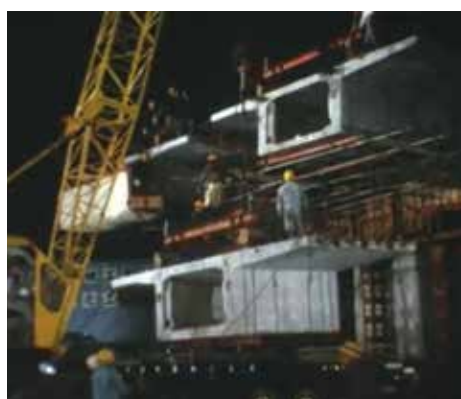
▲ 写真-4 深夜における架設状況
