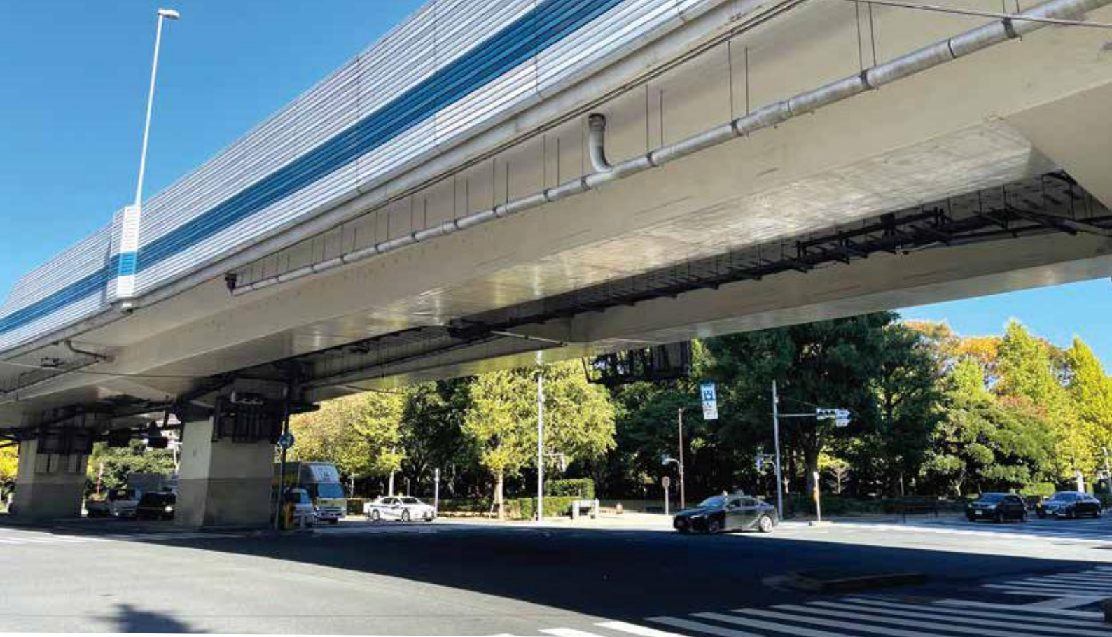
▲写真-1 現在の目黒架道橋
