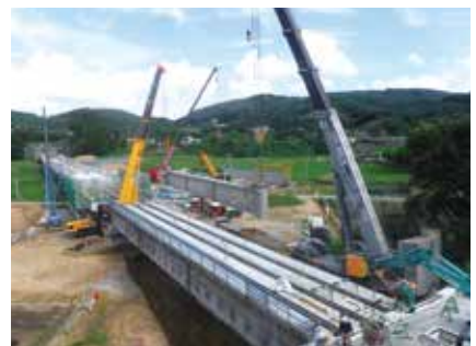
▲ 思い出の現場(架設状況)
