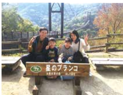
▲ 星のブランコ(木床版人道吊橋)
