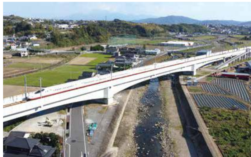
▲写真-2 第2本明川橋梁全景
