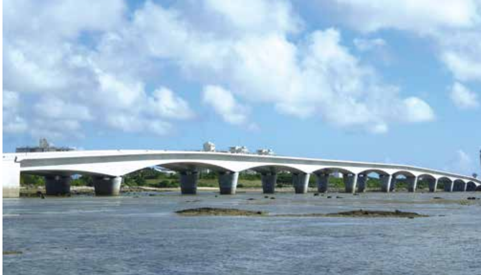
▲カーミラー橋 沖縄西海岸道路の埋め立て計画変更に伴い、平成30年に完成したPC11径間連続箱桁橋。塩害の激しい海上橋のため、大型架設作業車を用いて施工ブロック数を減らし、PC品質を確保。
