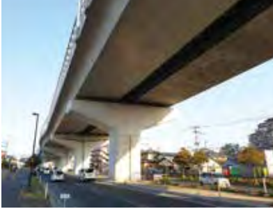
▲福岡高速5号線 PRC中空床版構造区間
