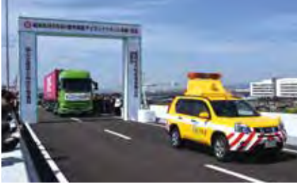
▲福岡高速6号線(アイランドシティ線)開通(令和3年3月)
