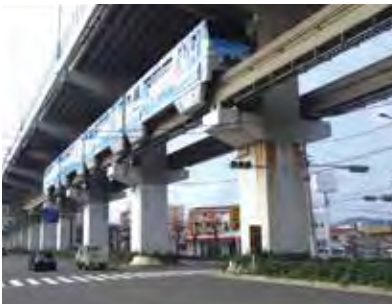
▲北九州高速1号線 モノレール一体構造区間
