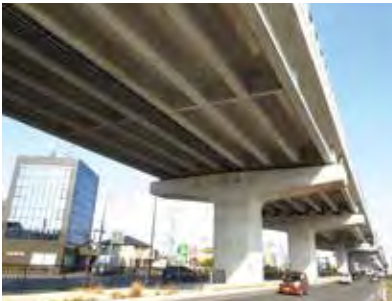
▲福岡高速5号線 PC少主桁構造区間
