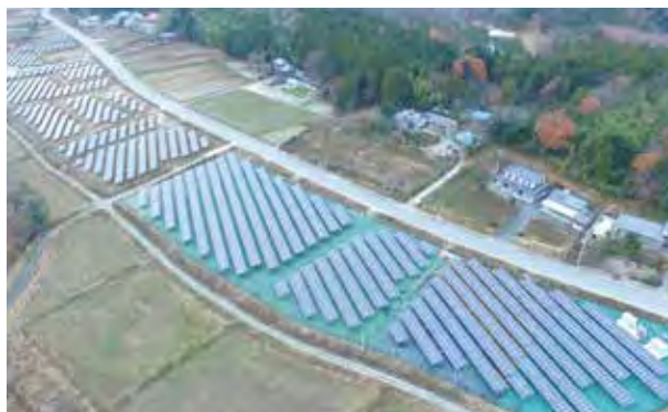
▲ 大熊町ふるさと復興メガソーラー発電所 2015年12月に運転を開始した発電所は、約3.2haの敷地に7704枚もの太陽光パネルを設置。広大な敷地の除草作業を軽減するため、6種類の除草シートを敷設して、その効果を長期的に検証している。
