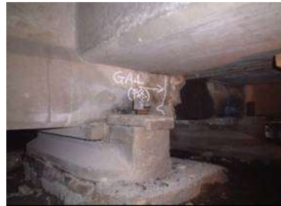
写真-1 既設鋼製支承
