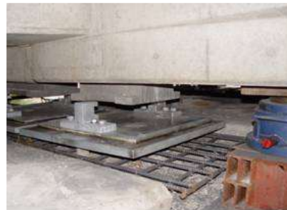
写真-2 支承取替え
