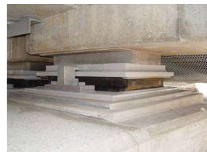
写真-3 水平反力分散ゴム支承
