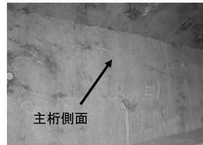
写真-1 主桁PC鋼材位置のひび割れ
