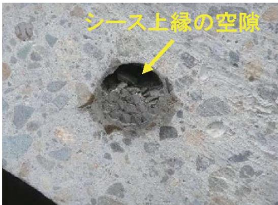
写真-4 グラウトの充填不良
