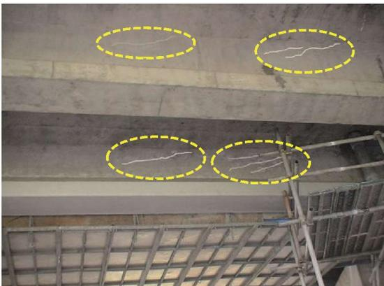
写真-6 グラウト充填不良によるひび割れ
