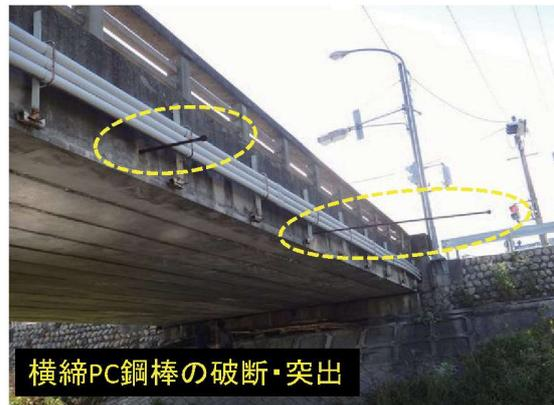
写真-5 グラウト充填不良によるPC鋼棒の破断
