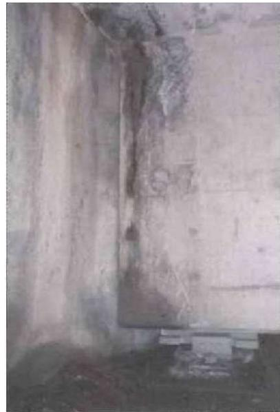
写真-2 凍結防止剤による塩害
