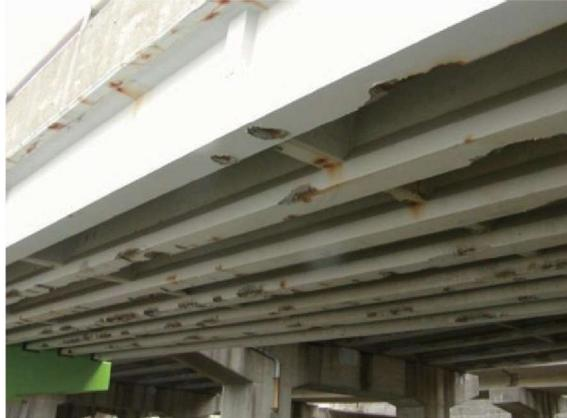
写真-1 飛来塩分による塩害
