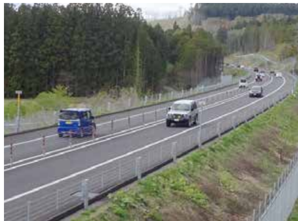
▲ 茂辺地木古内道路 開通後の状況
