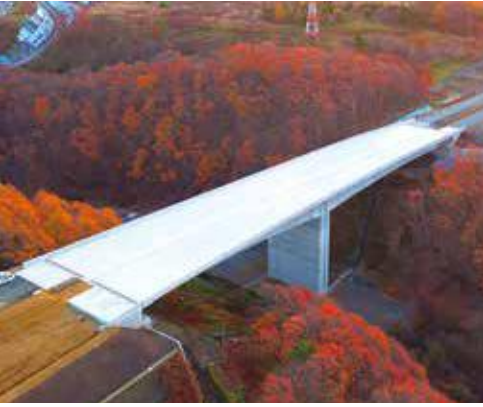
▲湯の沢川大橋 完成写真
