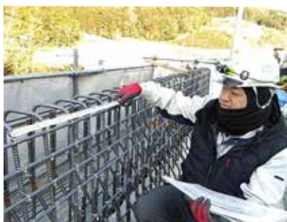
▲ 現場作業状況
