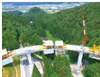
▲ 岐阜県飛騨市施工風景
