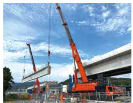
▲ 初めての現場(架設状況)
