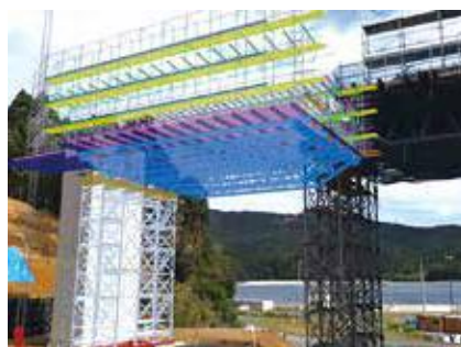
▲ MRを活用した干渉チェック(雄勝1号橋)
