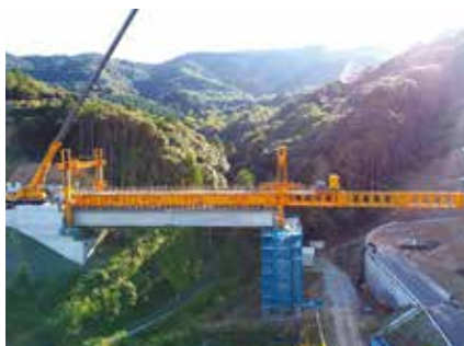
▲ 23号バイパス架設状況
