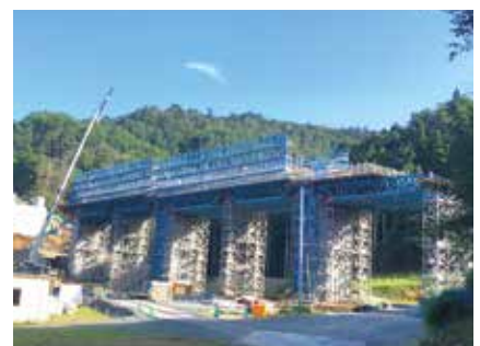
▲ 架設中(雄勝1号橋)
