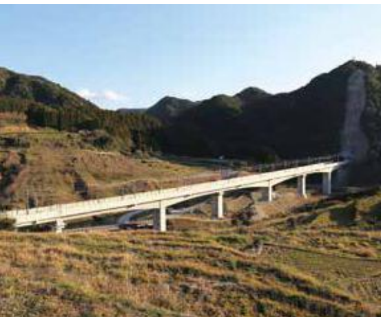
▲彼杵川橋りょう他2橋 片持ち架設された3連のPC2径間連続ラーメン箱桁橋。写真左から橋長110m、120m、120m。
