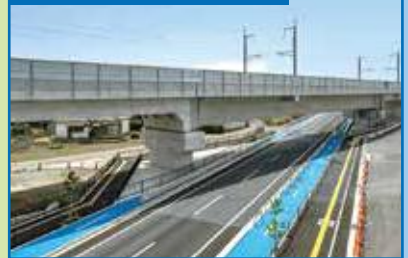
第一竹松架道橋
