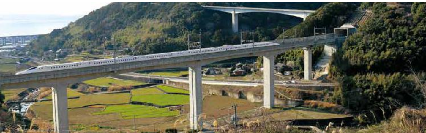
▲千綿川橋りょう(奥:大村湾グリーンロード) 塩鶴トンネルと千綿トンネルの間を流れる千綿川などを跨ぐ、PC4径間連続ラーメン箱桁橋。橋長213m、地上約40mの橋梁。
