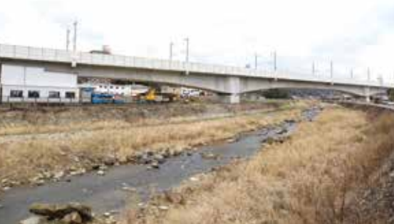
▲第2本明川橋りょう 一級河川本明川と市道を斜めにまたぐ、最大支間長115m・全長265mのPC連続箱桁橋。
