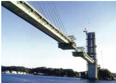
▲ 写真-2 張出し施工
