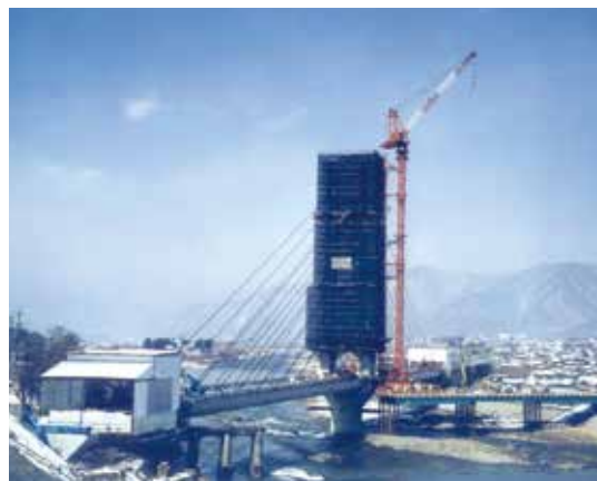
▲ 写真-3 張出し架設状況
