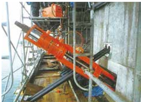
▲ 写真-3 斜材緊張
