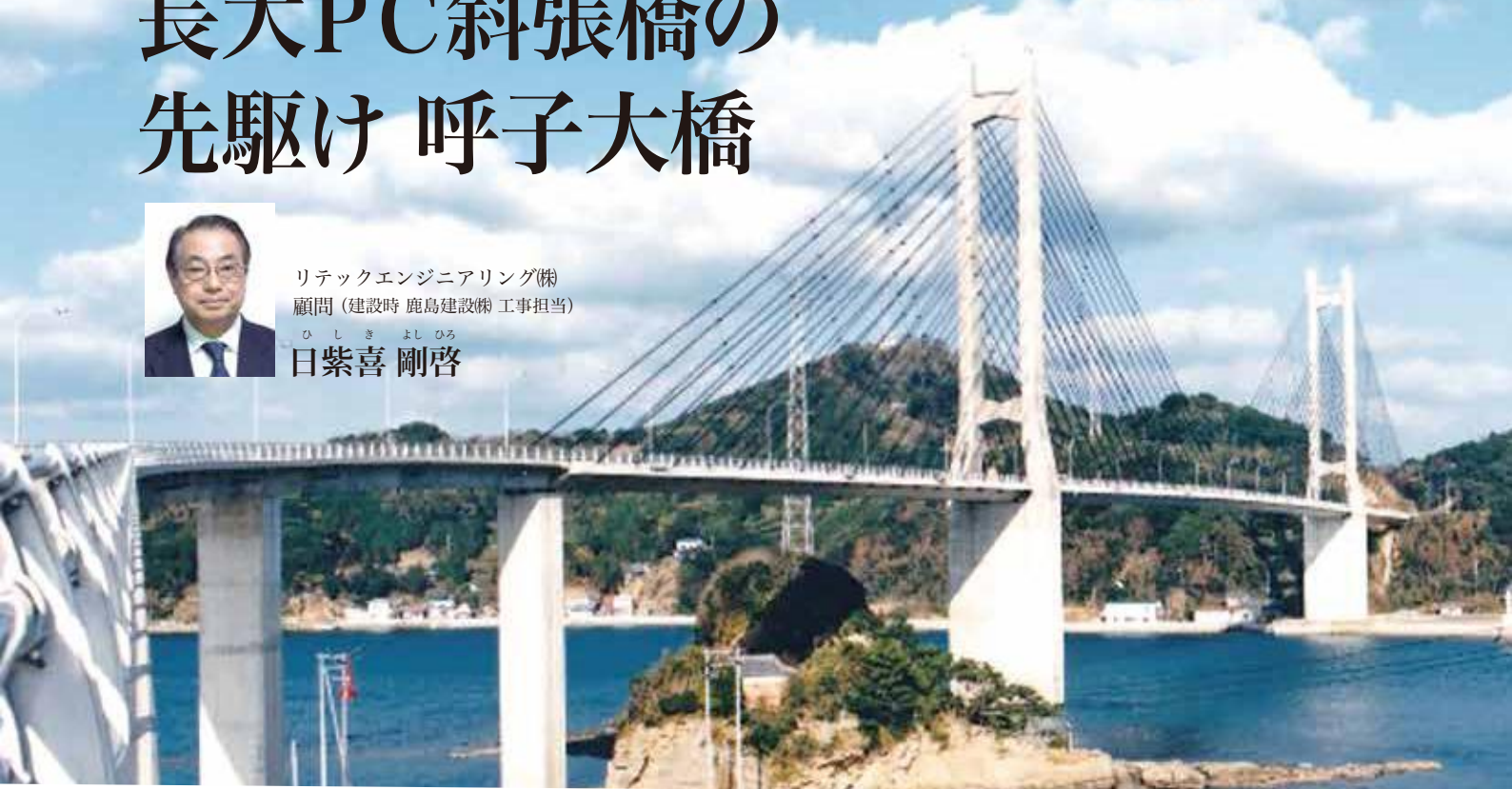
▲写真-1 呼子大橋全景
