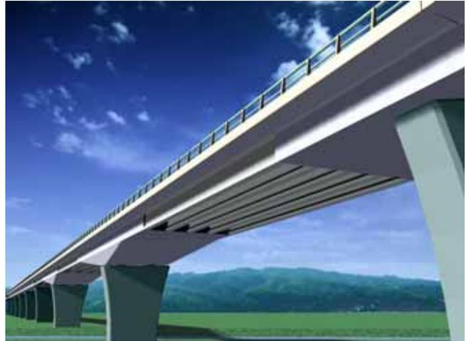
図-1.1 プレキャスト桁を用いたPC構造
