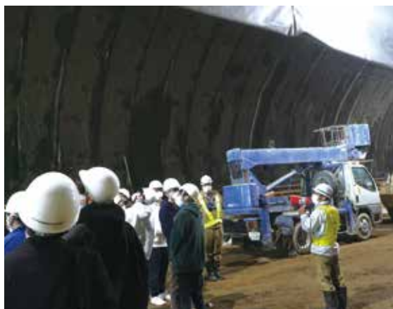
▲現場見学(東海環状自動車道御望山トンネル工事)
