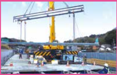
本町高架橋（上り線） 床版取替工事（p.34）
