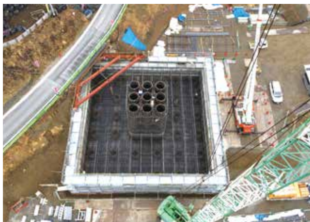
▲ 鋼管・コンクリート複合構造橋脚 施工状況
