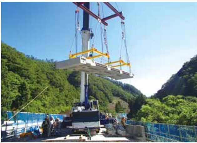
▲ 架設状況 (Dura-Slab)
