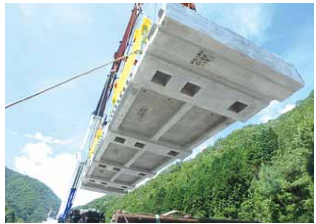
▲ 架設状況 (Dura-Slab)
