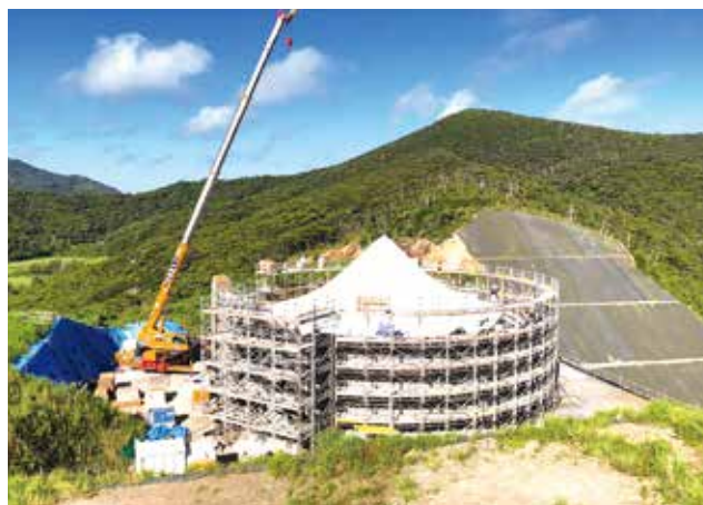
▲ エアドーム工法膜材展設状況
