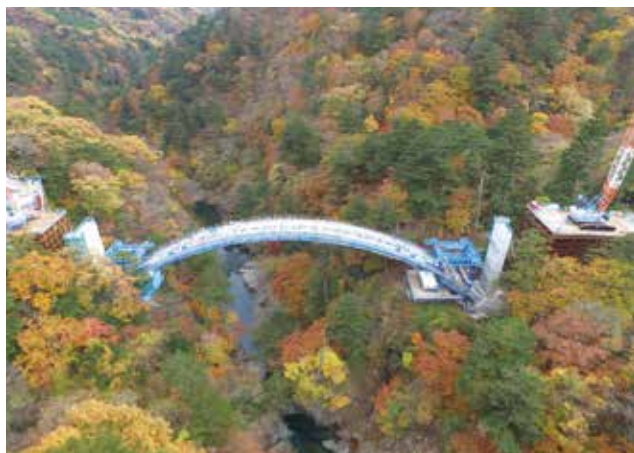
▲アーチ閉合状況
