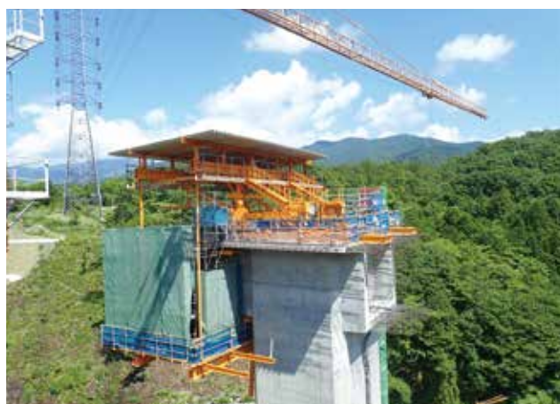
▲ 柱頭部の合理化施工状況(移動作業車 1 台での施工)
