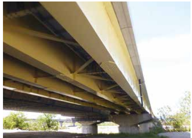
▲ 塗替塗装完了
