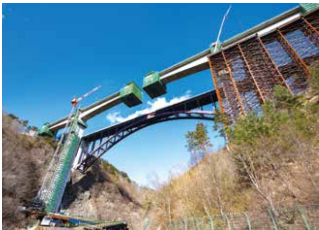
▲ 谷底より望む片持架設状況
