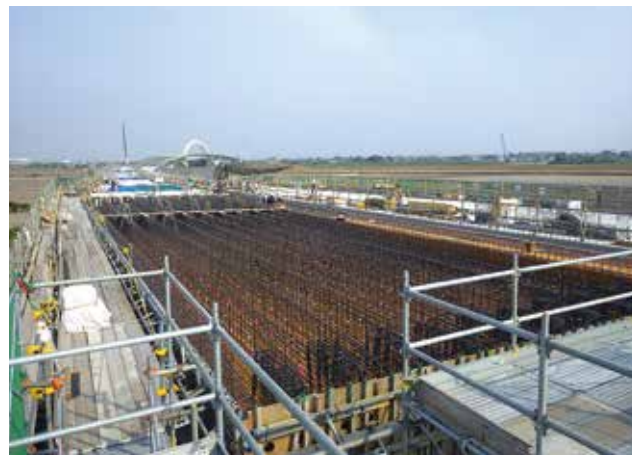
▲ 鉄筋組立状況
