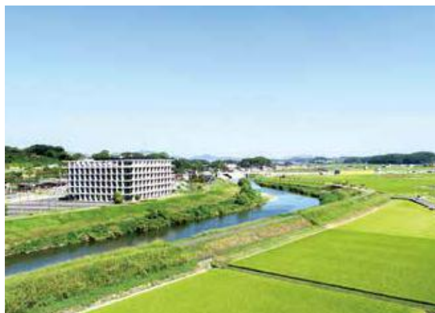
▲ 建物東側に遠賀川が流れる
