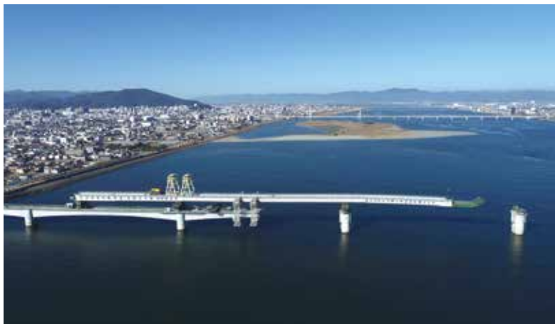
▲ 架設桁送り出し
