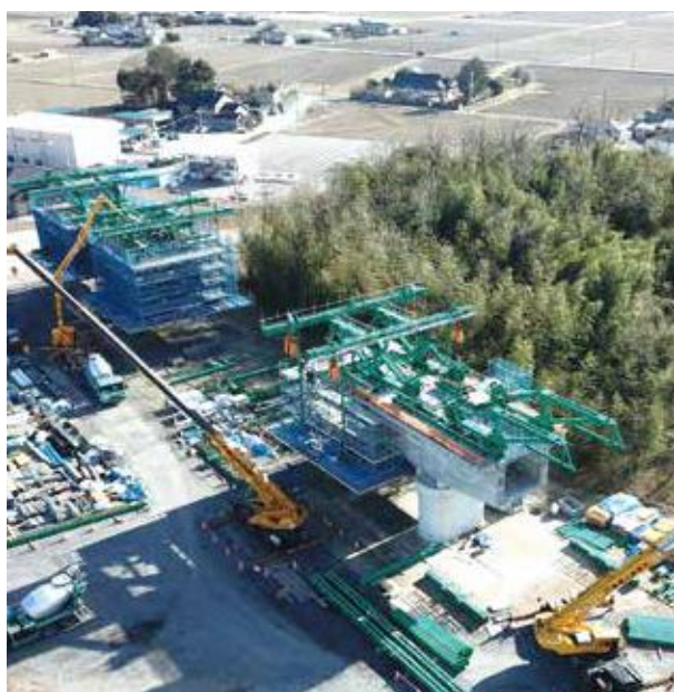
▲大型移動作業車による施工
