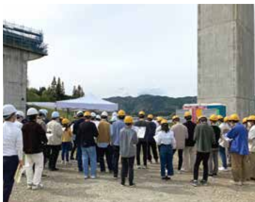
▲ 町方高架橋での現場実務研修の様子
