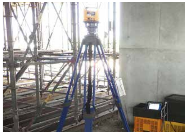
▲ 支保工沈下測定状況
