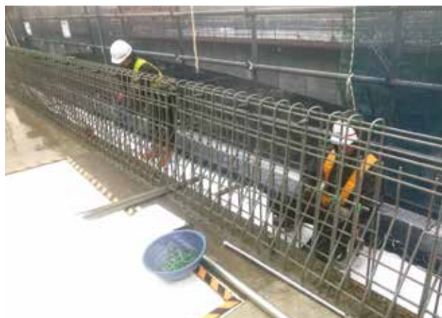
▲ 新しい防食鉄筋を採用した壁高欄の施工立況
