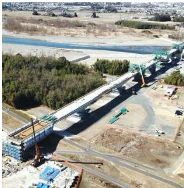
▲側径間ならびに中央閉合施工
