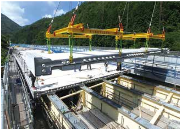
▲ 架設状況 (Dura-Slab)
