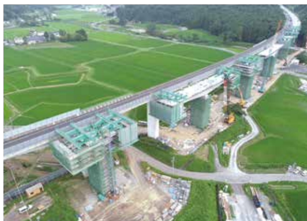
▲片持架設施工中：移動作業車12基同時稼働
