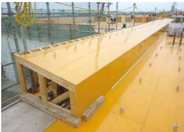
▲ 型枠のユニット化
