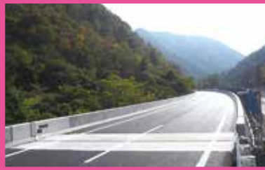
蓼野第二橋他3橋 床版取替工事（p.36）
