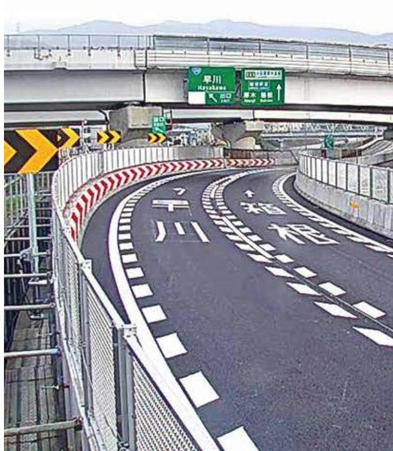
▲ 萬丈橋完成(早川Bランプ交差部)
