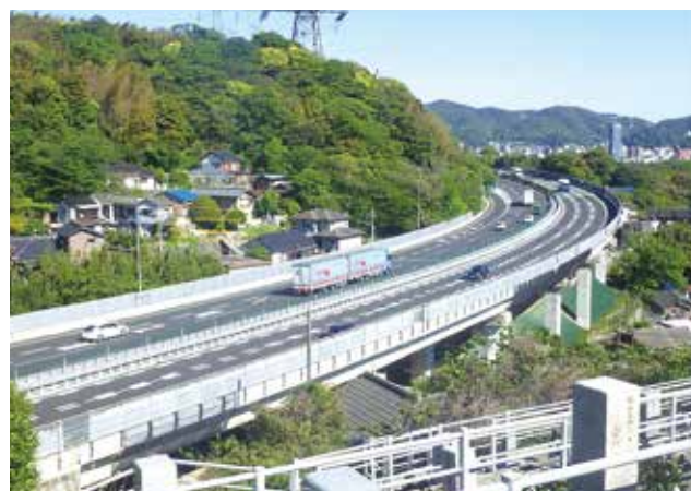
▲ 架橋地点(住宅街)
