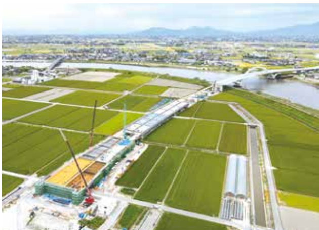
▲ 施工状況写真
