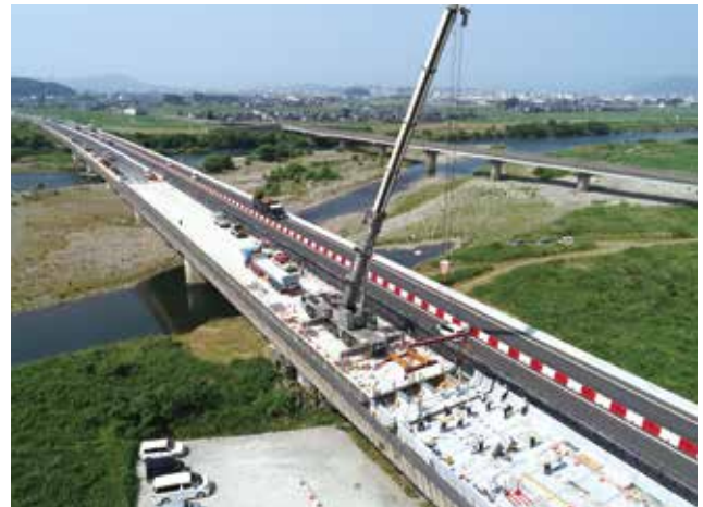
▲ プレキャスト床版架設
