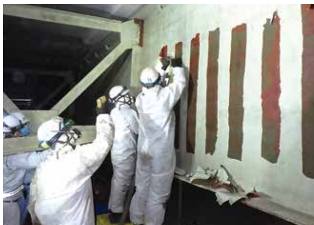
▲ 既存塗膜剥離状況 (IH工法)
