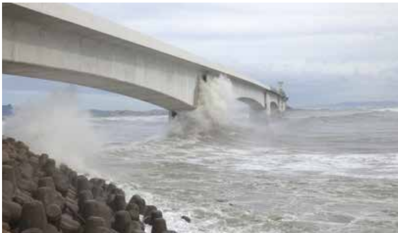
▲ 台風による波を受ける橋梁
