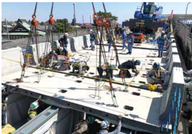
▲ 早川Bランプ橋施工中
