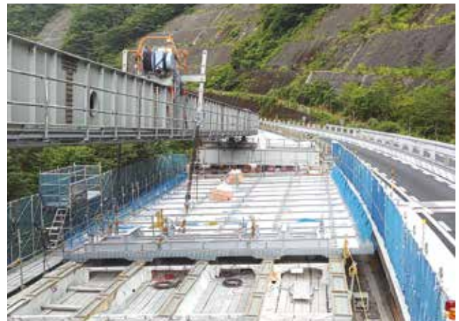
▲ 架設状況 (架設桁)
