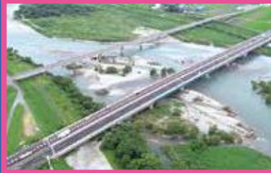
九頭竜川橋 床版取替工事（p.38）
