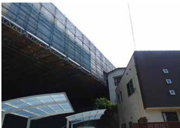
▲ 住宅近接部の吊り足場および側部防護
