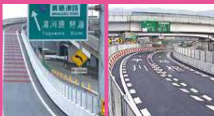
早川 B ランプ橋 萬丈橋 床版取替工事 (p.40)
