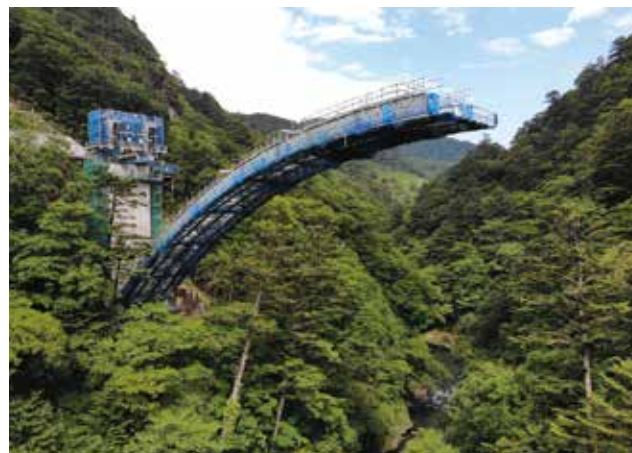
▲斜吊りの鋼材メラン材
