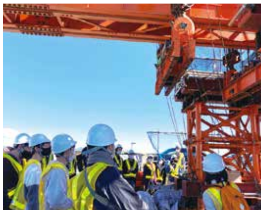
▲ 富田第一跨道橋の現場見学会
