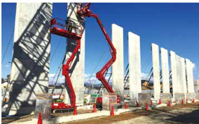
▲ 壁柱の建て起こし完了
