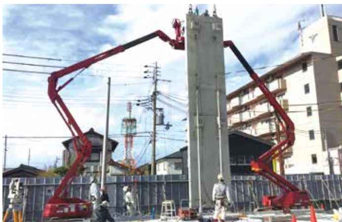
▲ 壁柱のPC緊張状況
