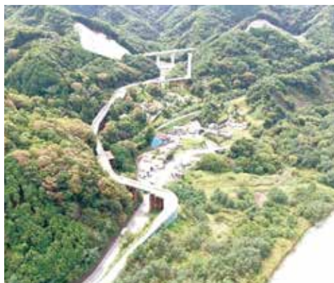
▲ 下八木沢工事用道路
