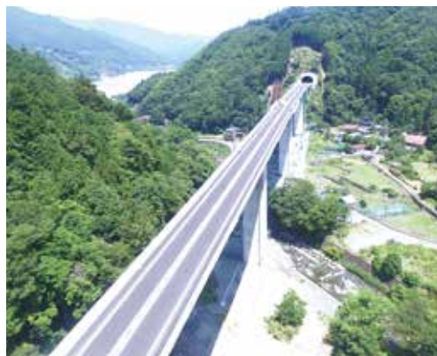
▲ 椿川橋(PC5径間連続ラーメン箱桁橋)
