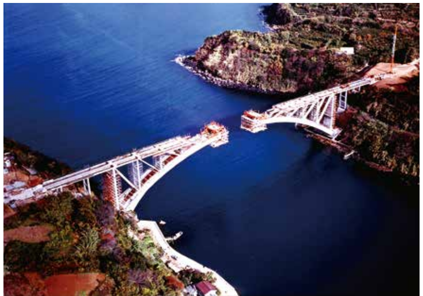
▲ 外津橋 トラス張出し工法による施工
