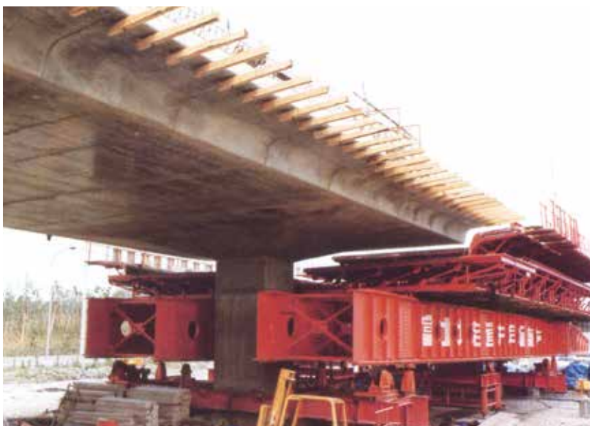
▲ BT208工区(首都高湾岸線) 橋脚を避けて移動する開閉式型枠可動支保工での施工
