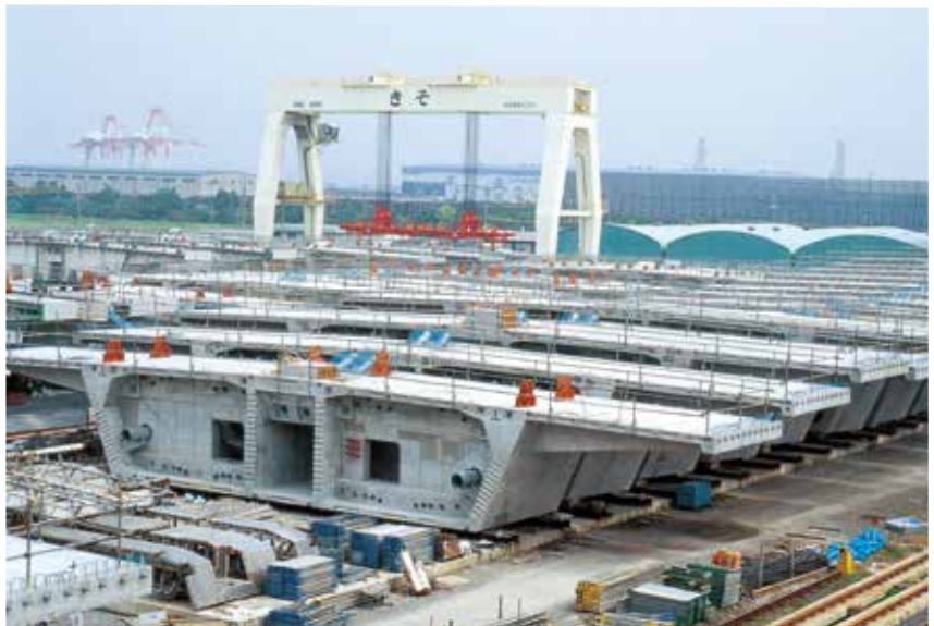
▲ 損斐川橋 セグメント仮置場
