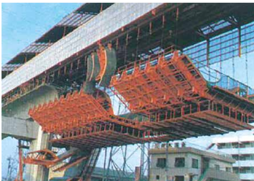
▲ AS21工区(首都高6号三郷線) 桁下空間の条件に左右されない移動吊支保工での施工
