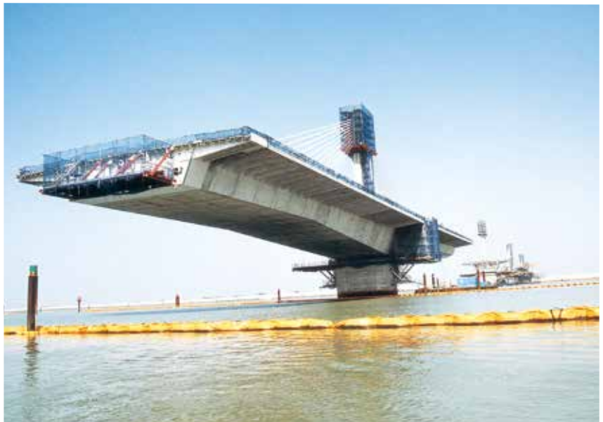
▲ 損斐川橋 張出施工中
