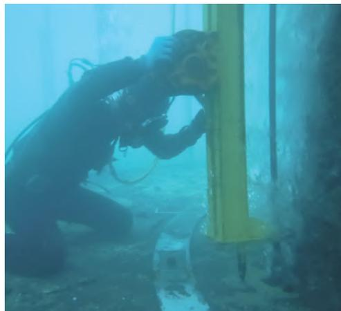
▲ 潜水士による軸方向鉄筋削孔作業
