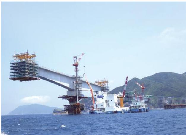
▲ミキサー船でのコンクリート打設状況
