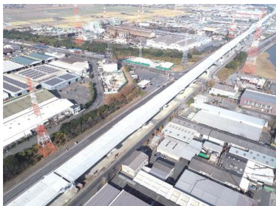
▲名古屋第二環状自動車道 飛鳥村木場区間
