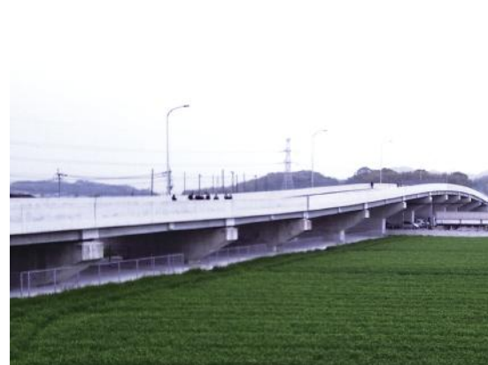
▲福岡県道高田山川線バイパス 今福陸橋
