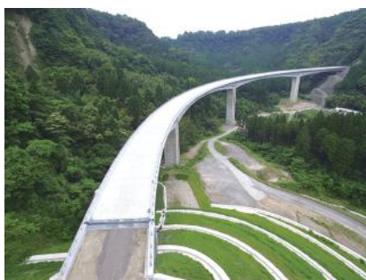
▲ 初めての片持架設工法の現場
