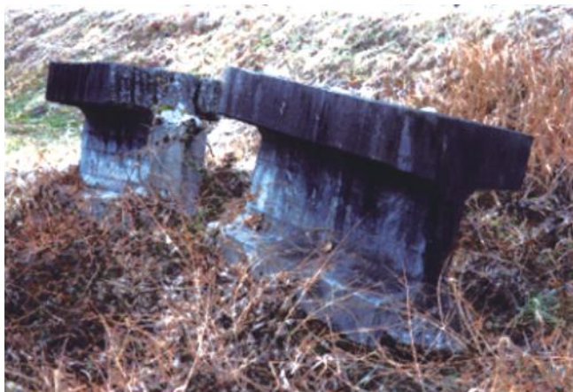
▲橋梁近くの供試体
