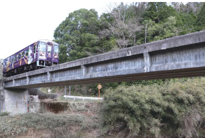
▲現在の状況(写真提供:甲賀市)
