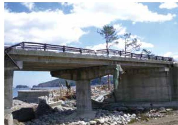
▲ 国道45号 波板橋(単純プレテンションT桁橋 若手県大槌町)
