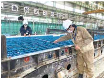
▲ PC床版の打設前型枠測定状況
