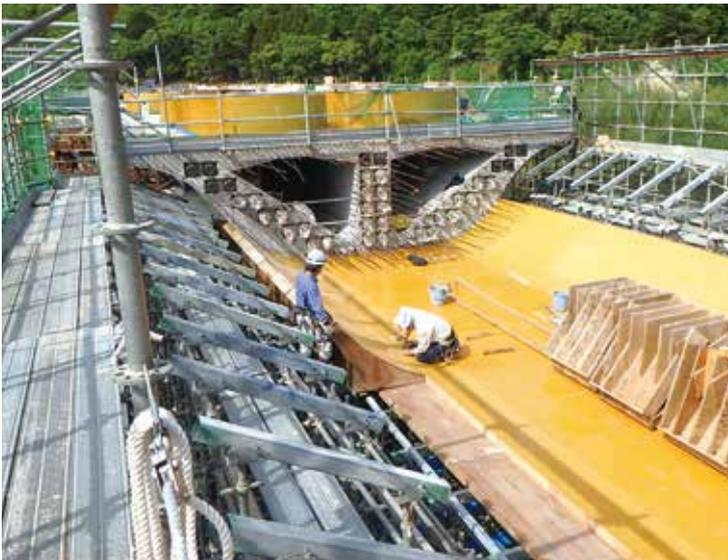
▲ 型枠 (櫛枠) 組立状況
