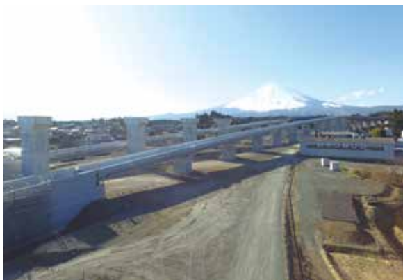
▲ 国道138号バイパスぐみ沢OFFランプ橋
