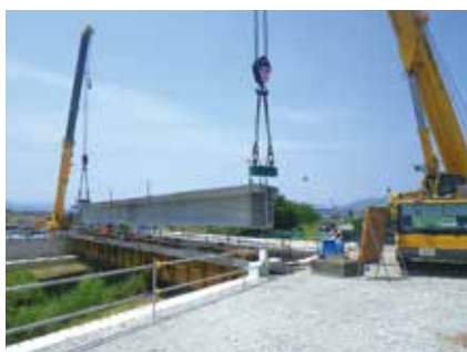
▲ ポステンT桁橋の現場
