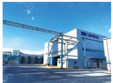
▲ 川田建設那須工場
