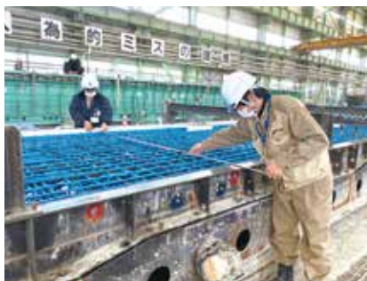
▲ PC床版の打設前型枠測定状況
