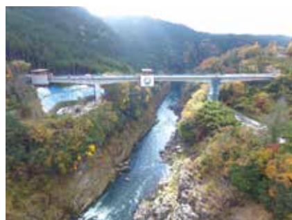
▲ PCラーメン箱桁橋の現場
