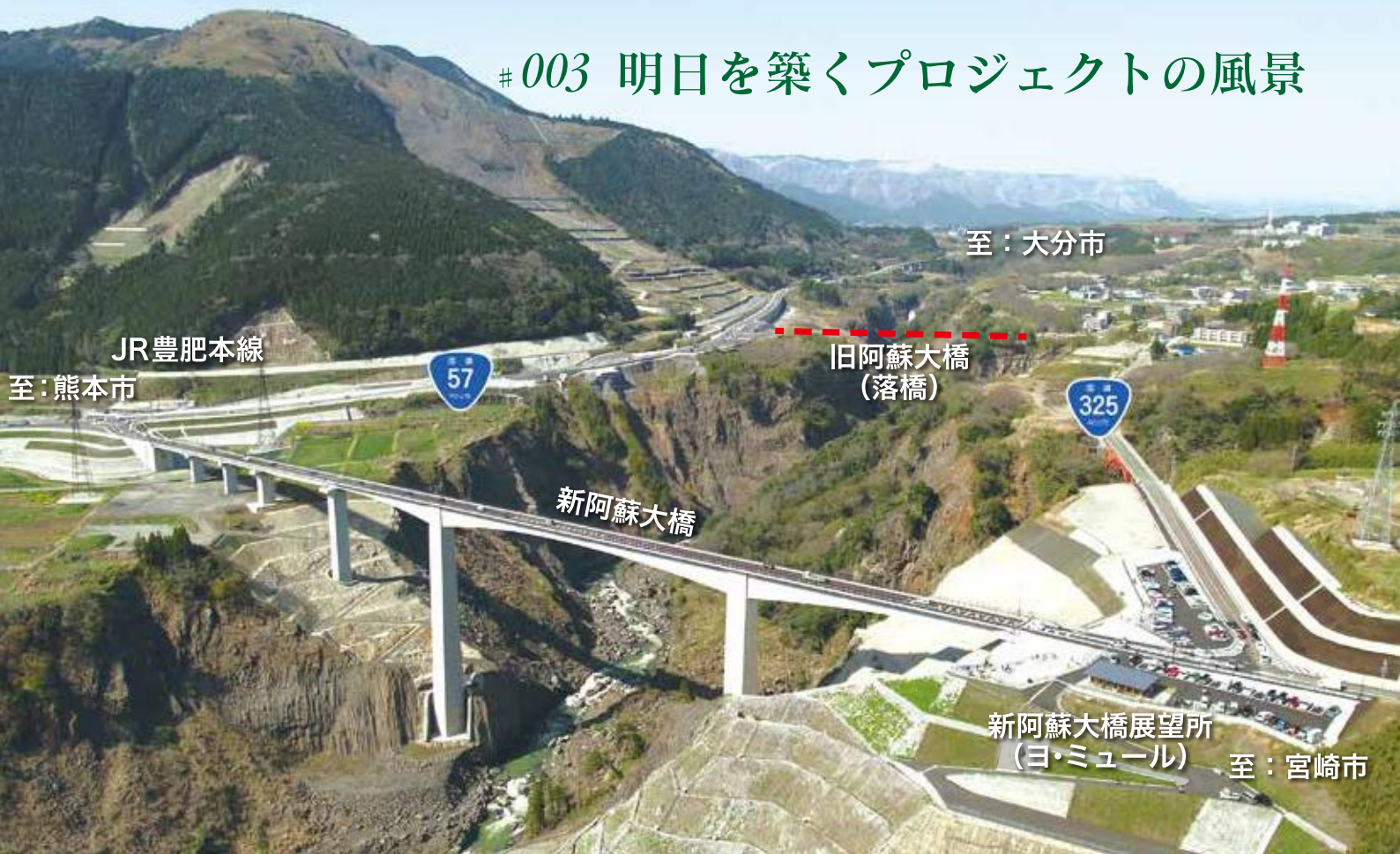
▲写真-1 地震により落橋した旧阿蘇大橋と新阿蘇大橋
