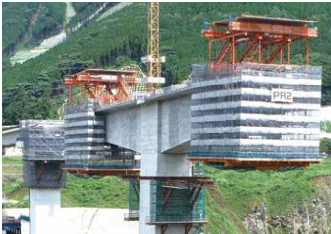
▲写真-5 超大型移動作業車による片持ち架設
