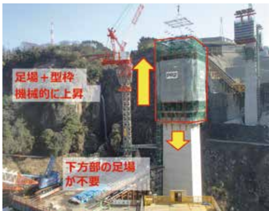
▲ 写真-4 橋脚の施工状況(クライミング工法)
