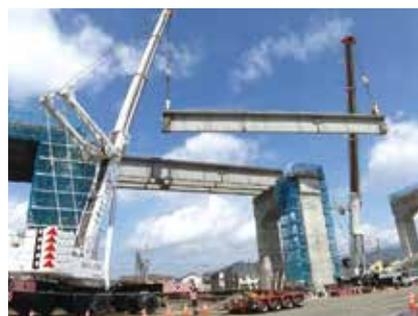
▲ 北陸新幹線: 桁架設の様子
