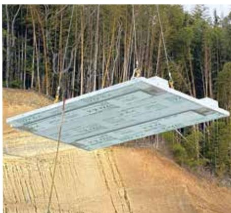
▲ DM板下面に予め工場で断熱材打ち込み
