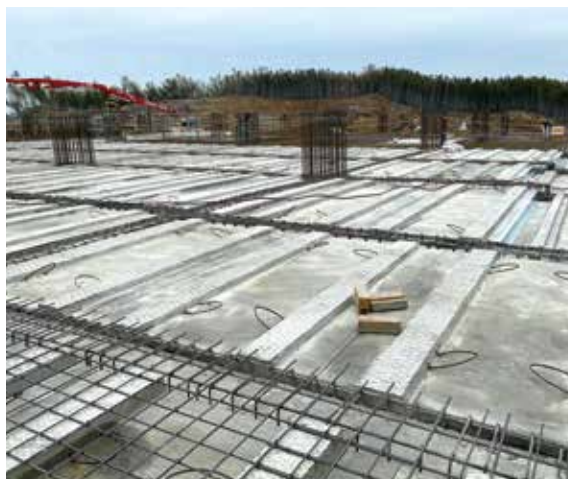
▲ 敷設完了（配筋前）
