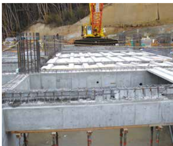
▲ ノンサポートでの敷設状況
