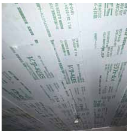
▲ DM板敷設と同時に断熱工事も完了
