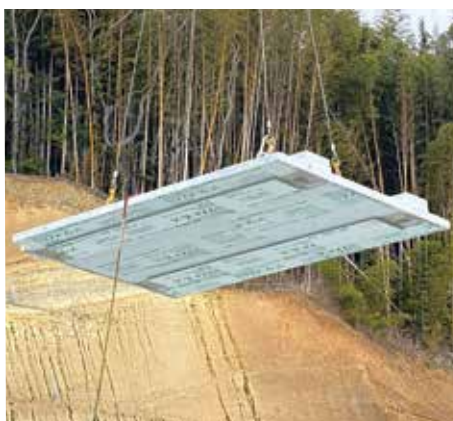
▲ DM板下面に予め工場で断熱材打ち込み
