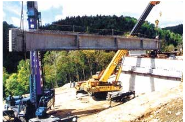
▲ プレキャスト桁の架設
